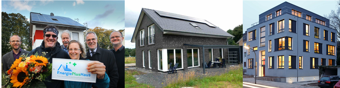
Das 1. EnergiePlusHaus 2012 im Neubaugebiet Kahle Hege, Foto: RN, D. Menne Das 1. EnergiePlusHaus mit Batterie 2016, Neubaugebiet Rahmer Wald Das 1. EnergiePlus-Mehrfamilienhaus 2015, Baulücke Kaiserviertel, Foto: C. Suhan
