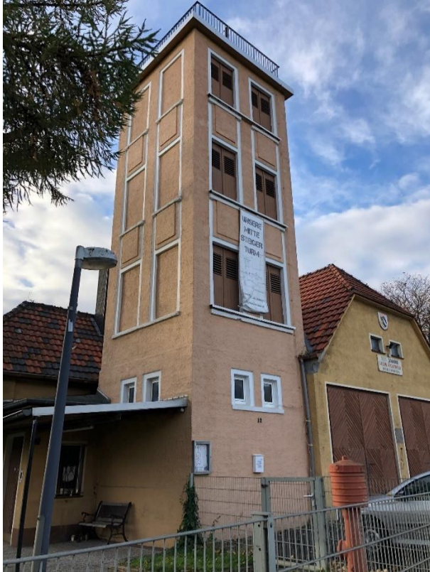
Der Steigerturm und das Feuerwehrgerätehaus in Berghofen vor dem Umbau
