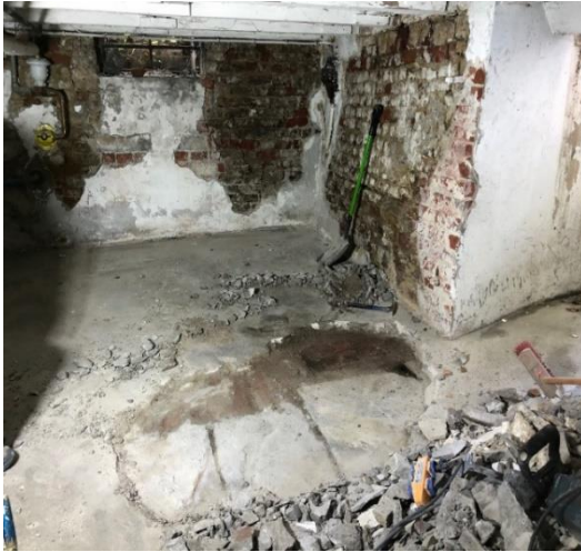
Der z.T. freigelegte Boden des Bierkellers
