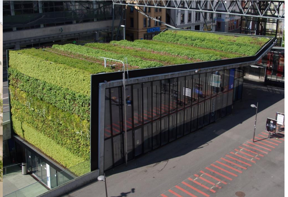
Dachbegrünung (Lausanne, Schweiz)
