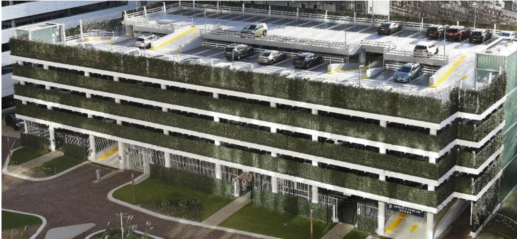
Fassadenbegrünung eines Parkhauses (Rotterdam)
