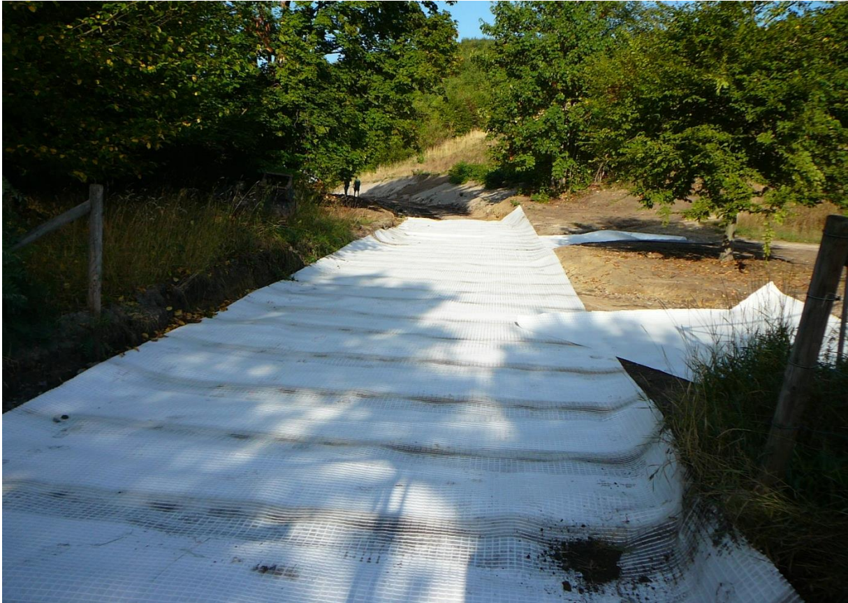
Zur Erhöhung der Tragfähigkeit des Untergrundes wurden Matten eingebaut.
