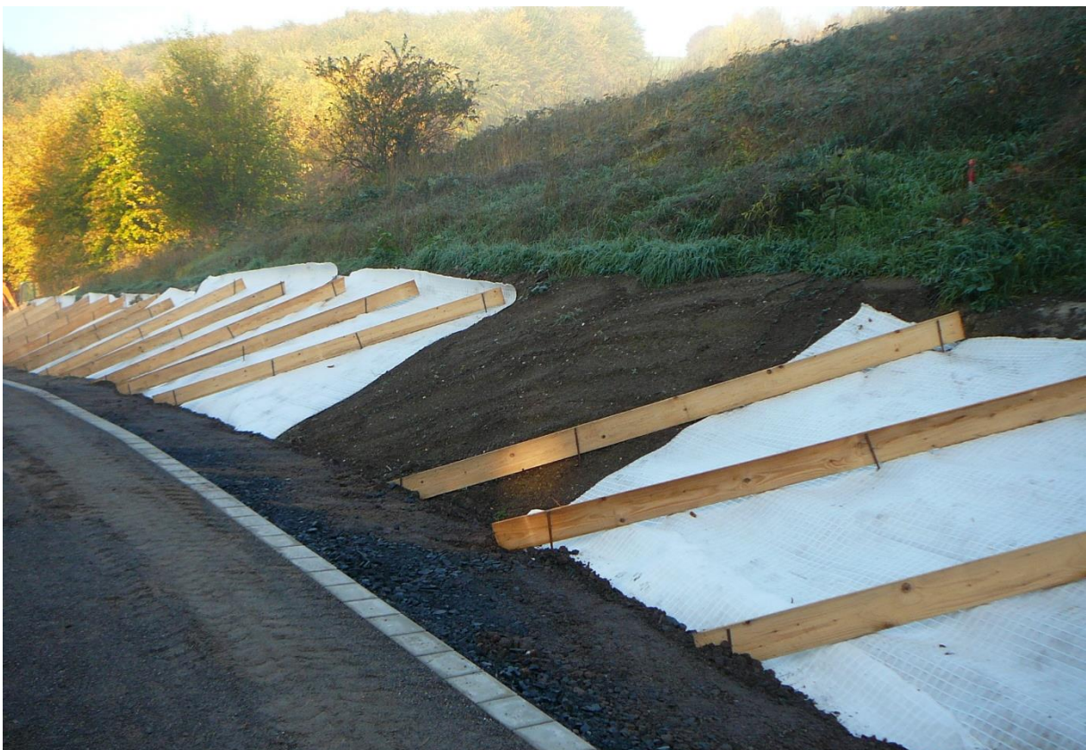
Schwartenbretter dienen im Untergrund der Stabilisierung der Böschungen.
