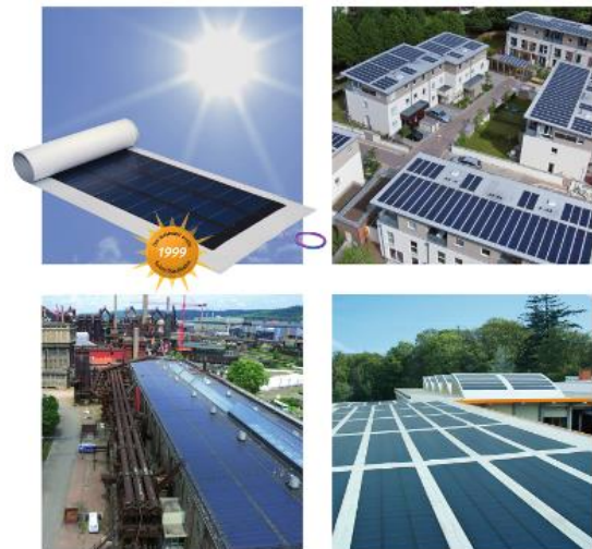
Abbildung 67: Solardachbahnen (Quelle: Innovation City Management GmbH)
