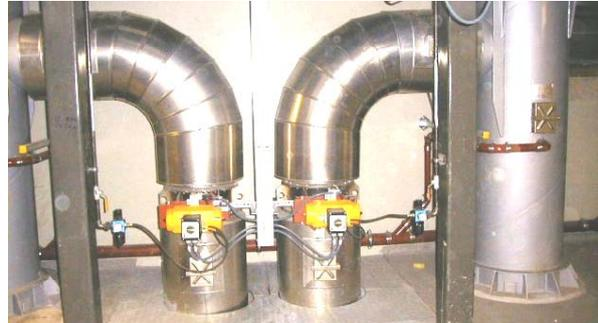
Der Bypass wird außerdem genutzt, um die Restgase bei Stillstand der Öfen (z.B. nachts und am Wochenende) direkt über den Kamin abzuführen..
