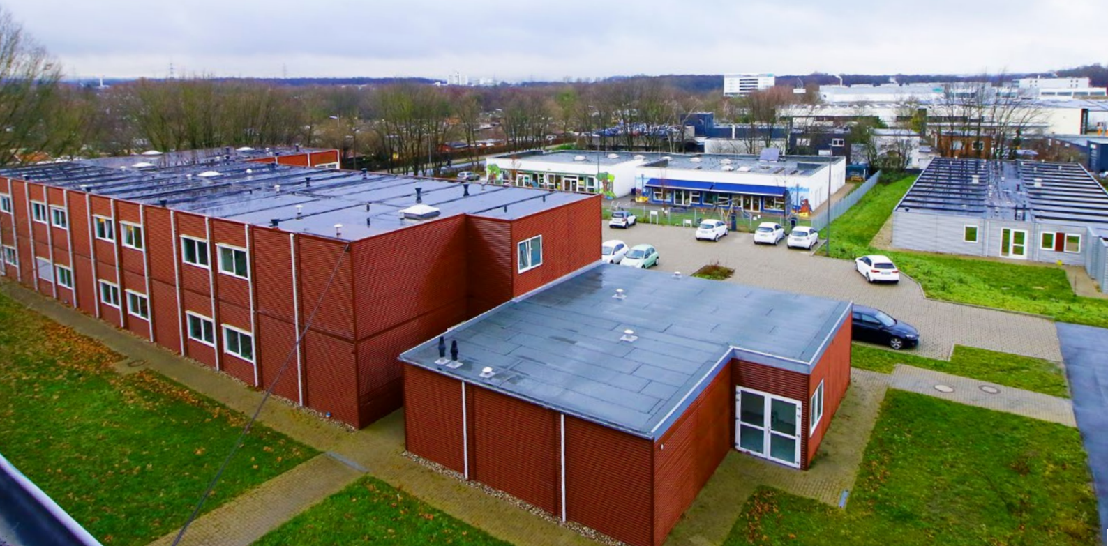
Büro-Modulbauten ehem. Frenzelschule
