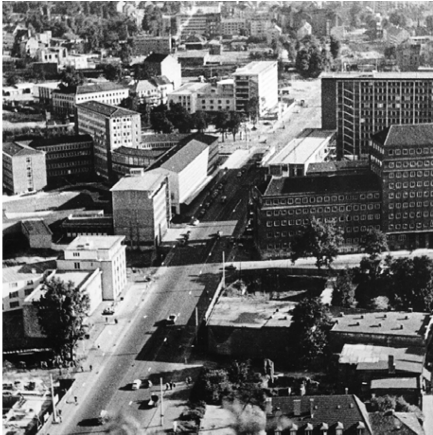
Abb. 35: Schrägluftbildaufnahme über die Kleppingstraße Richtung Südwall, ca. 1960er Jahre
