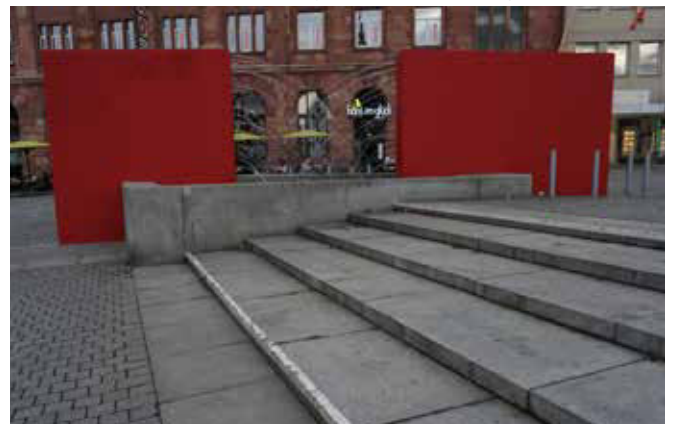
Abb. 116: Treppenanlage am Hansaplatz, 2022
