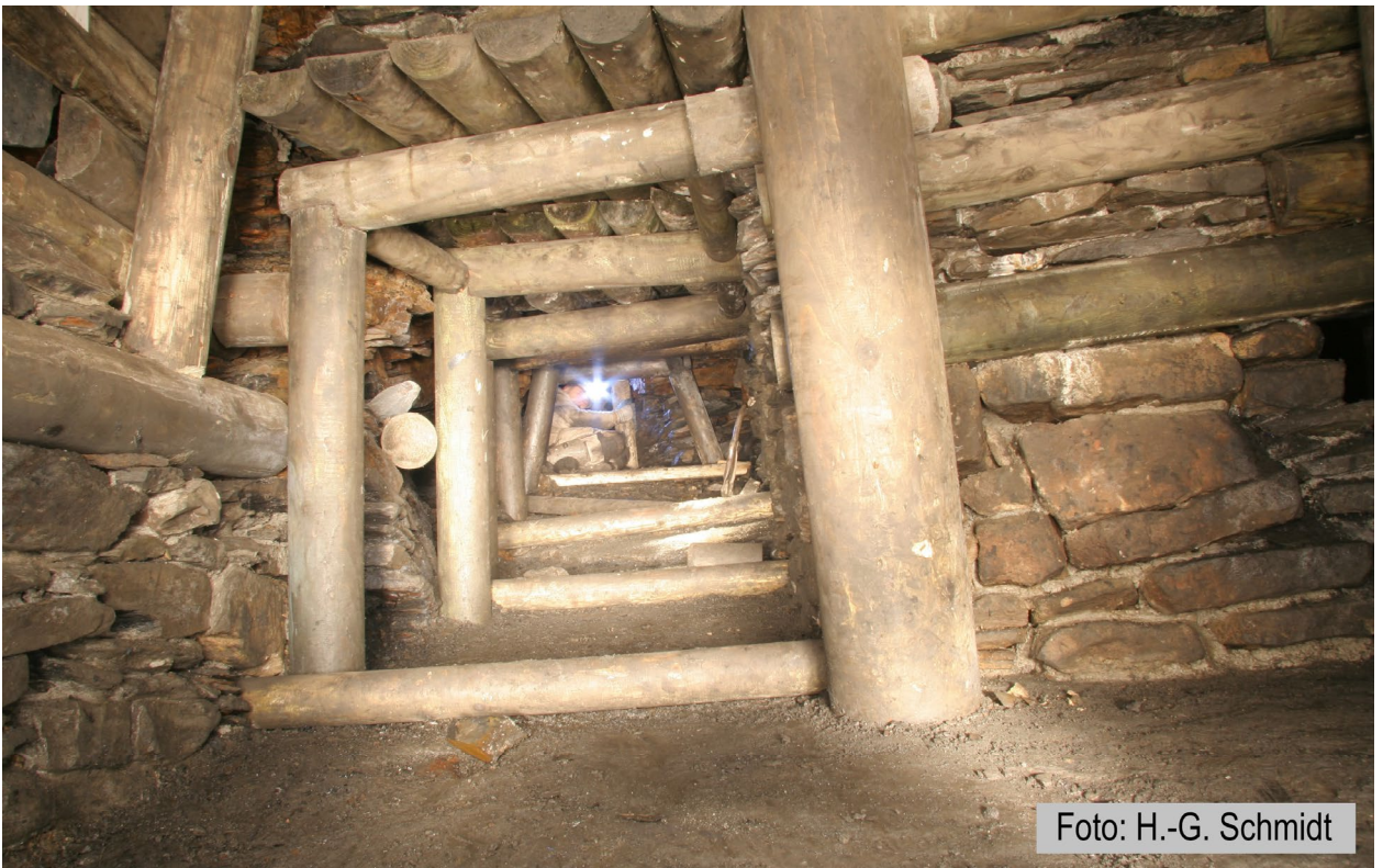
Blick von einer Förderstrecke in ein Aufhauen nach oben. (Foto Herbert-Gerhard Schmidt)
