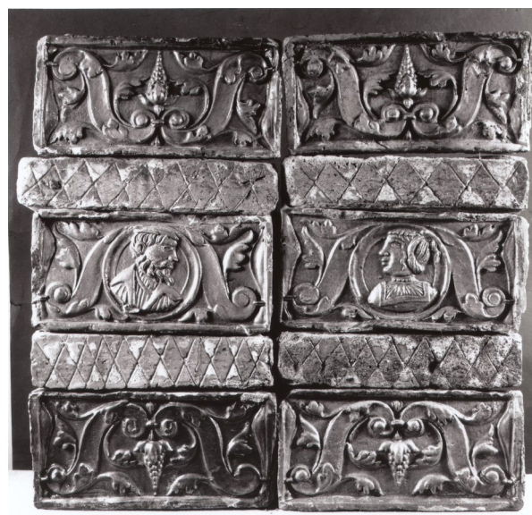
Detailblick auf die Backsteinfassade des ehemaligen Gebäudes an der Wißstraße.
