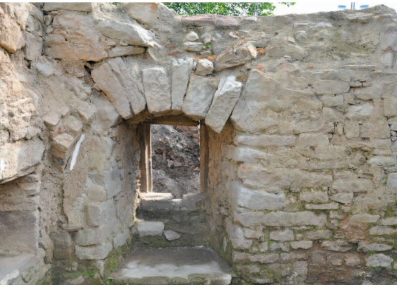
Die Wandöffnung in der Südwand von innen. Besonders deutlich zeigt sich die scharf profilierte Rinne in der oberen Sohlbank.
