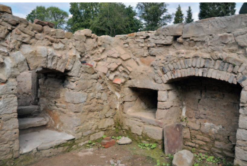
Die innere Ecke von Nord- und Ostwand mit den Ansätzen der Kreuzgewölbedecke aus Backsteinen und Resten einer blauweißlichen Farbfassung.
