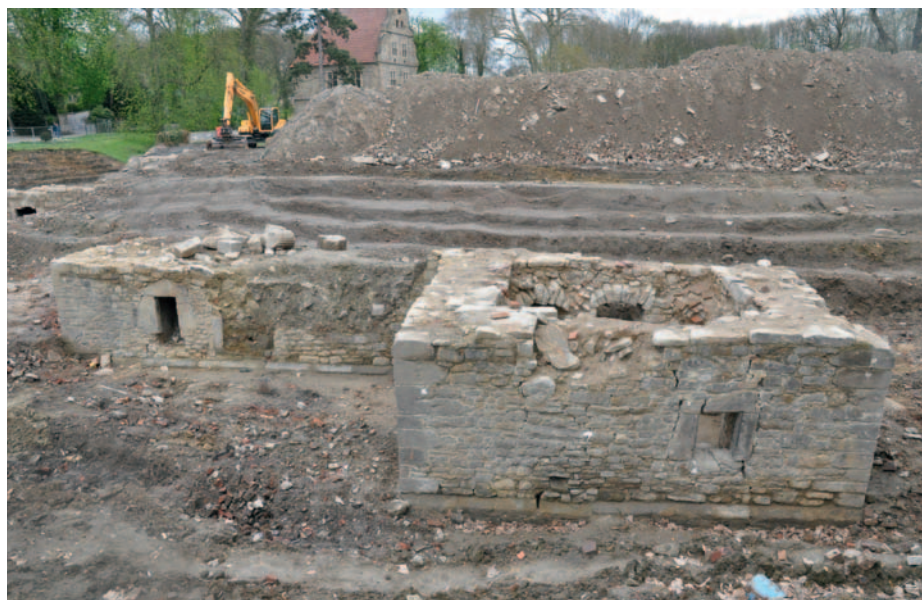
Turm und Burghaus von Süden nach der Freilegung. Nachvollziehbar sind die Mauerstärken der Turmwandung und der verhältnismäßig kleine Innenraum. Gut erkennbar sind die Spuren des Bombentreffers in der Südwand des angrenzenden Gebäudes.
