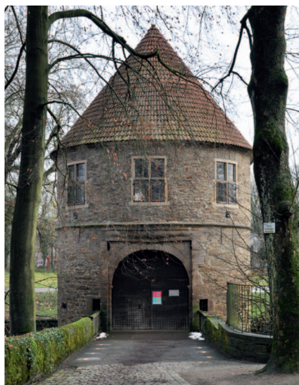
Die hufeisenförmig gerundete Westseite des Torhauses von Haus Brüninghausen.
