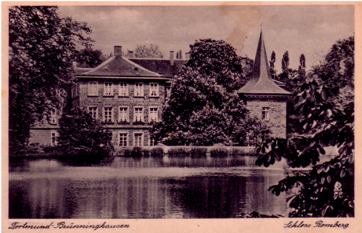
Schloss Romberg von Süden auf einem Foto aus den ersten Jahren des 20. Jahrhunderts. Die Fassade des zweigeschossigen Turmes wird durch ein einfaches Gurtgesims gegliedert und passt nicht zum links erkennbaren Gebäude des 19. Jahrhunderts, nur der Helm und das als Zahnstockfries ausgeführte Kranzgesims weisen in das 19. Jahrhundert. Das durch die Ausgrabungen freigelegte Nachbargebäude des Turmes ist durch einen Baum verdeckt.
