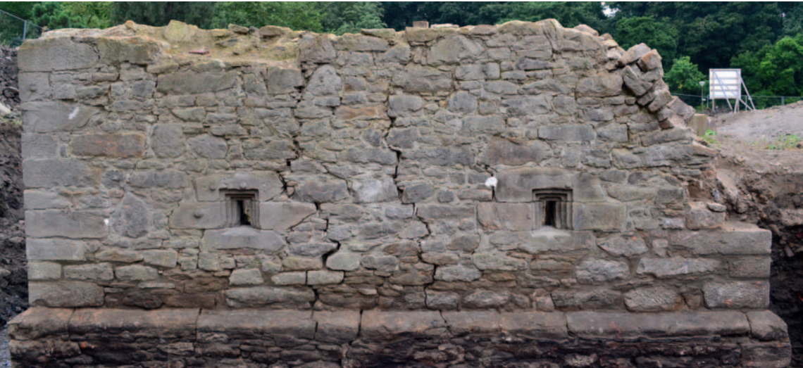
Die Ostwand des Turmes von außen mit zwei Maul- bzw. Treppenscharten sowie Halbkugeln auf den Gewänden und der Eckquaderung.
