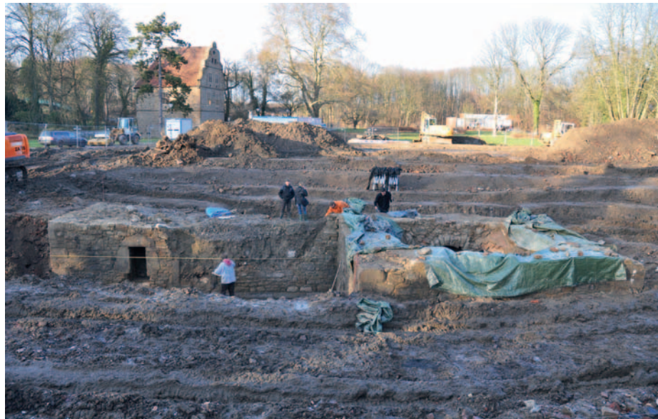
Turm und Burghaus von Süden während der Freilegung.
