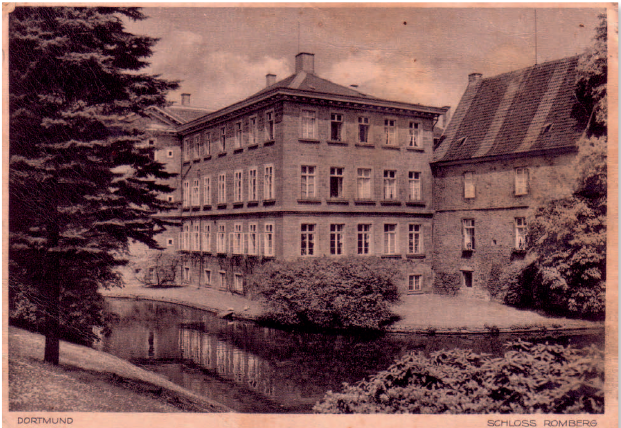
Von der Südwestseite zeigt sich auf einem Foto das Nachbargebäude des Turmes von Schloss Romberg. Es handelt sich um ein ebenfalls zweistöckiges Gebäude mit Gurtgesims und Untergeschoss direkt über dem Wasserspiegel. Der Baustil des Hauses mit hohem Dach, die Stockwerksgliederung und Fensteranordnung sprechen für eine Entstehungszeit in der Renaissance.
