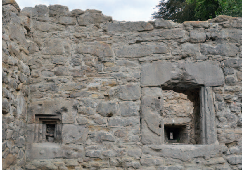
In der Außenansicht der Westseite eine Fensternische und eine Treppenscharte im Vergleich. Die Treppenscharte ist blind, d. h. sie wurde bei Anlage des Verbindungsganges zwischen Turm und angrenzendem Gebäude zugesetzt.
