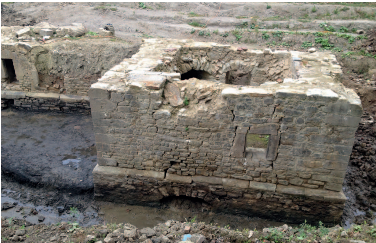
Die Südwand von außen mit einer Wandöffnung während der Ausgrabung mit Teilfreilegung des Fundamentes mit Entlastungsbogen.
