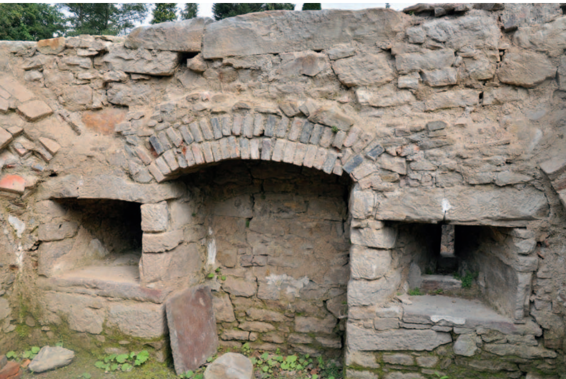
Die Ostwand des Turmes von innen mit den beiden Scharten sowie einer außen nicht sichtbaren Wandnische mit Ziegelgewölbe. Die Nische wurde im 19. Jahrhundert recht rigide zwischen die beiden Schartenöffnungen gesetzt.
