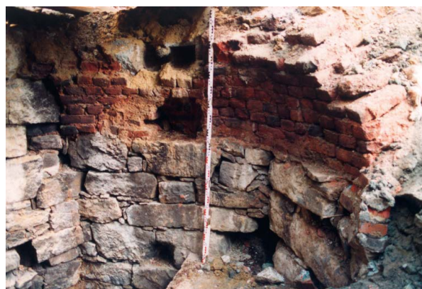
Blick in das Innere der Brunnenröhre des Marktbrunnens während der Ausgrabungen. Gut zu erkennen ist die nachträglich aufgesetzte, aus Ziegeln gemauerte Kuppel und darunter die sechseckige Röhre aus Sandsteinen mit den Balkenlöchern.
