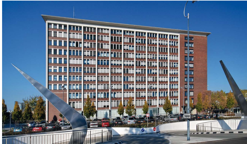
Stadthaus am Südwall mit Tiefgarageneinfahrten von Süden.
