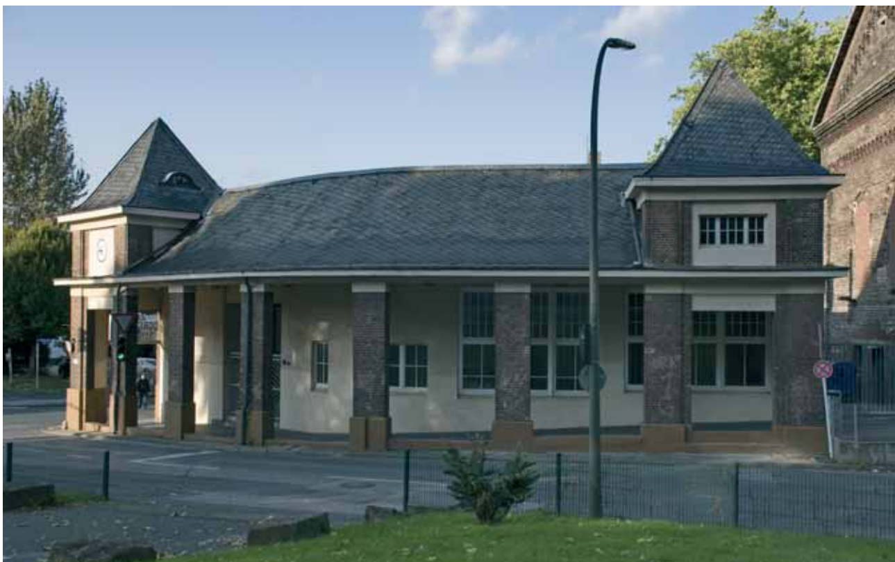
Abb. 2 Das Pförtnerhaus der ehemaligen Zeche Dorstfeld steht seit 1983 unter Denkmalschutz.
