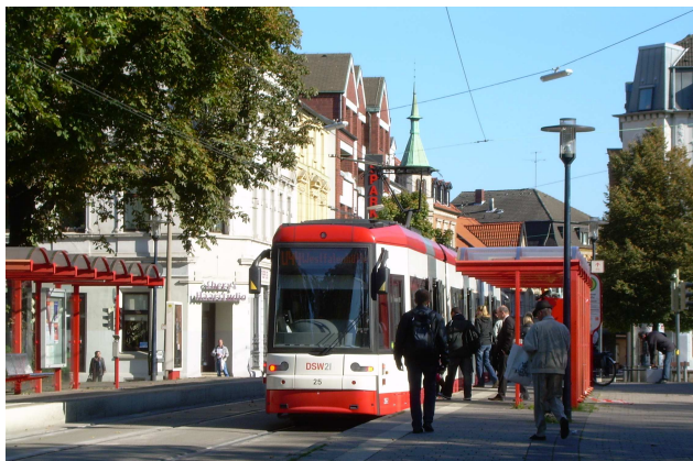
Abbildung 28: Stadtbahnhaltestelle Wittener Straße
