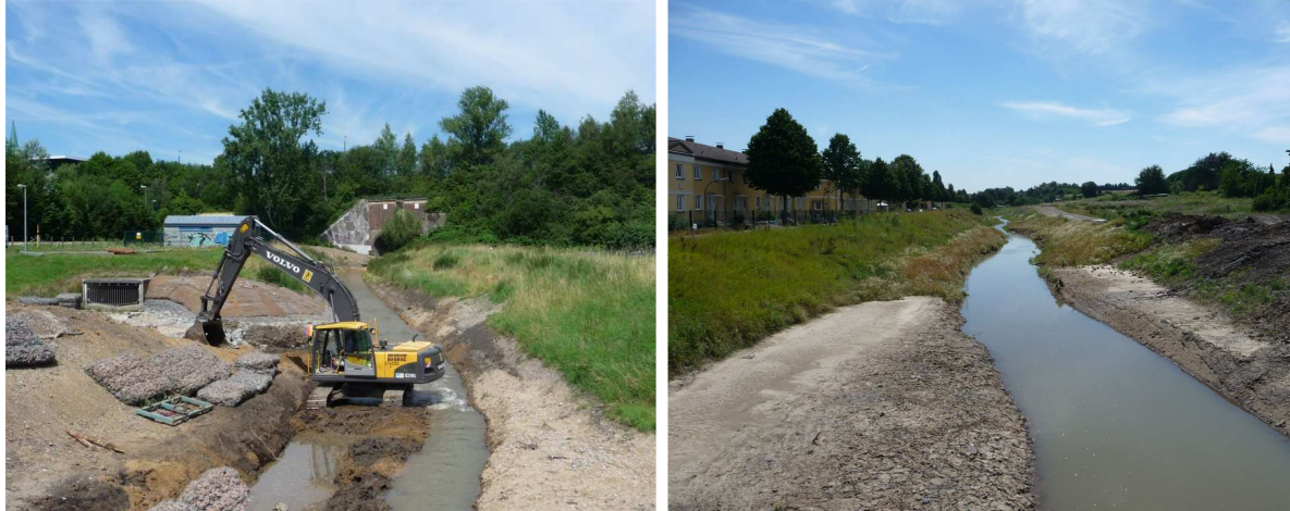
Abbildung 24: Der Emscherumbau auf Höhe der Straße Am Mühlenberg
