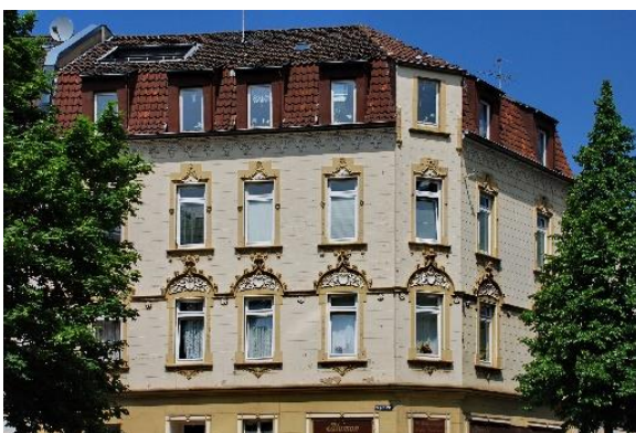
Abbildung 24: Neugotisches Wohn- und Geschäftshaus im Hörder Neumarktviertel
