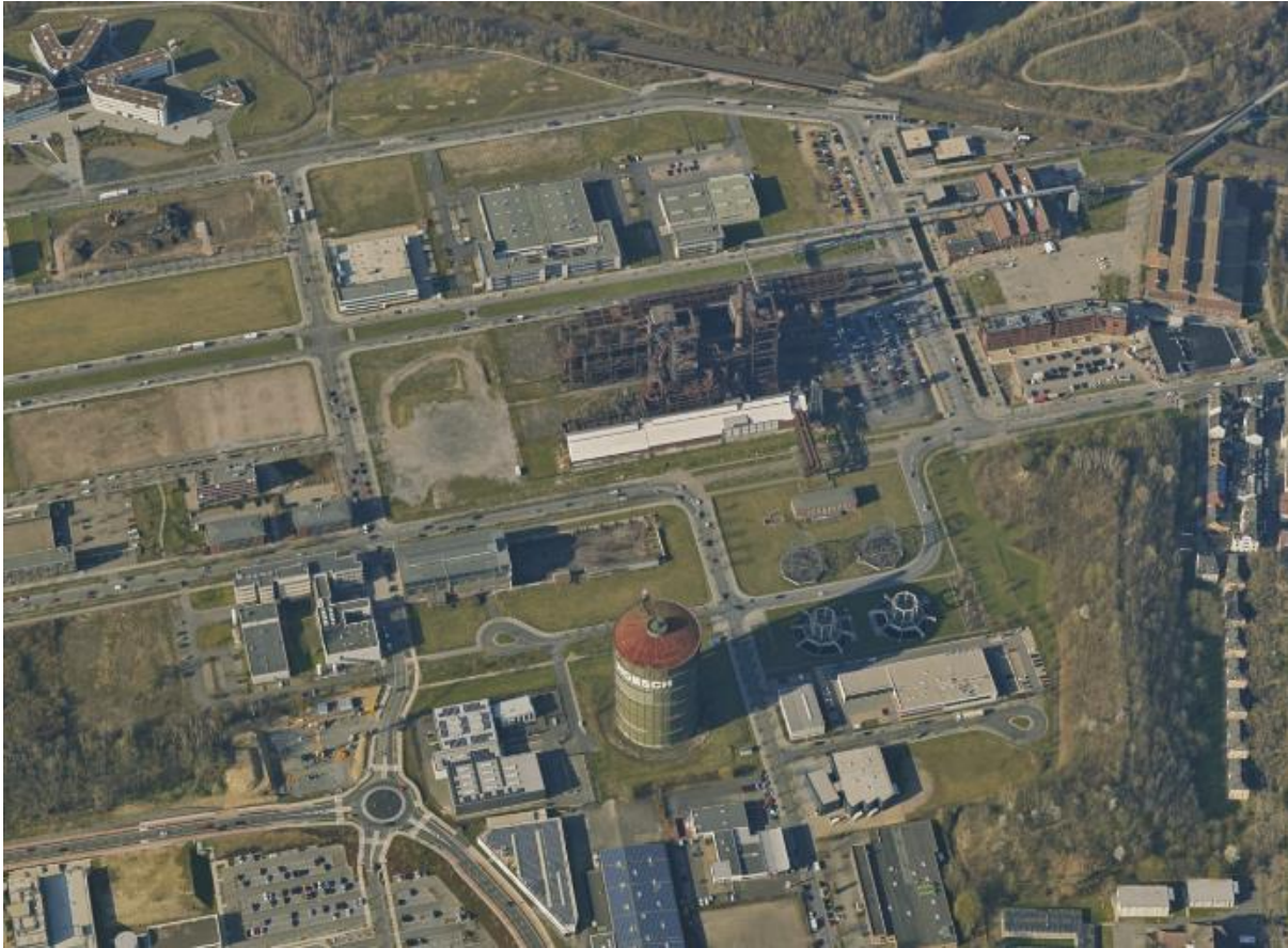
Abbildung 7: PHOENIX West, Hochofen, Gasometer und Hallen am PHOENIX - Platz
