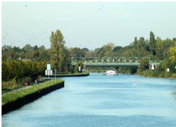
Straßenbrücke und Leitungsbrücke über den Dortmund-Ems-Kanal von Süden gesehen
