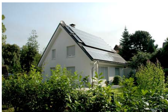
Photovoltaikanlage im Wohngebiet Rittershofer Straße
