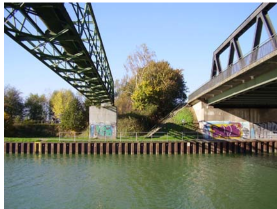
links Leitungsbrücke und rechts Kanalbrücke Ellinghauser Straße
