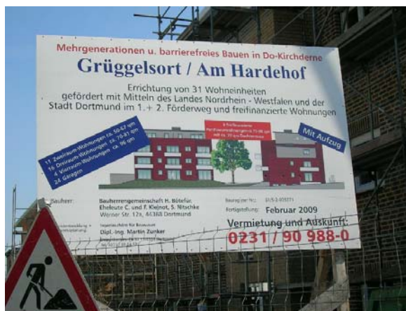
Baustellenschild und zukünftige Darstellung
