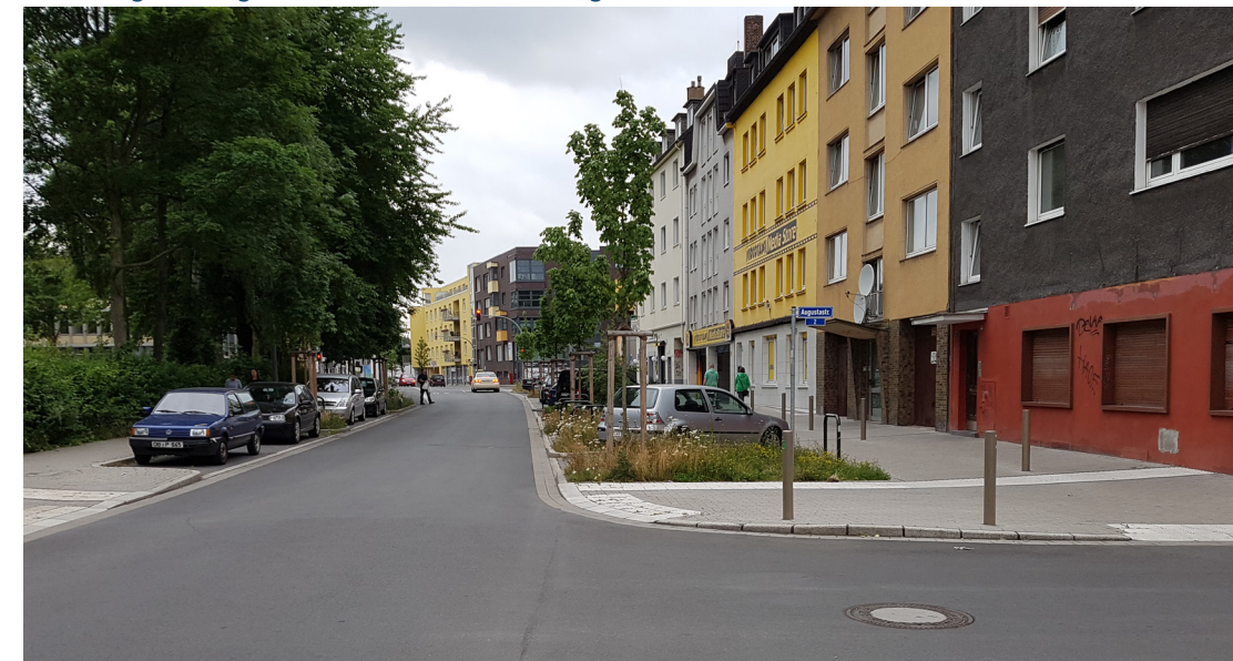
Abbildung 18: Umgestalteter Straßenraum - Lange Straße Dortmund
