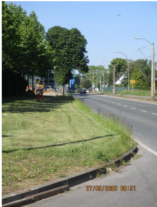
Blickrichtung Westen Standpunkt: Einfahrt TEDi
