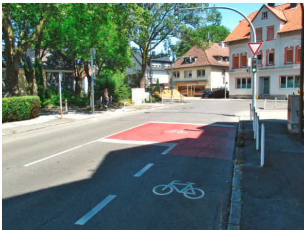
Kreuzung Grotenbachstraße/Löttringhauser Straße: Die aufgeweitete und vorgezogene Radaufstellfläche am östlichen Ende der Grotenbachstraße ermöglicht Radfahrenden ein verbessertes Linksabbiegen und bringt sie ins Sichtfeld der Autofahrenden.
