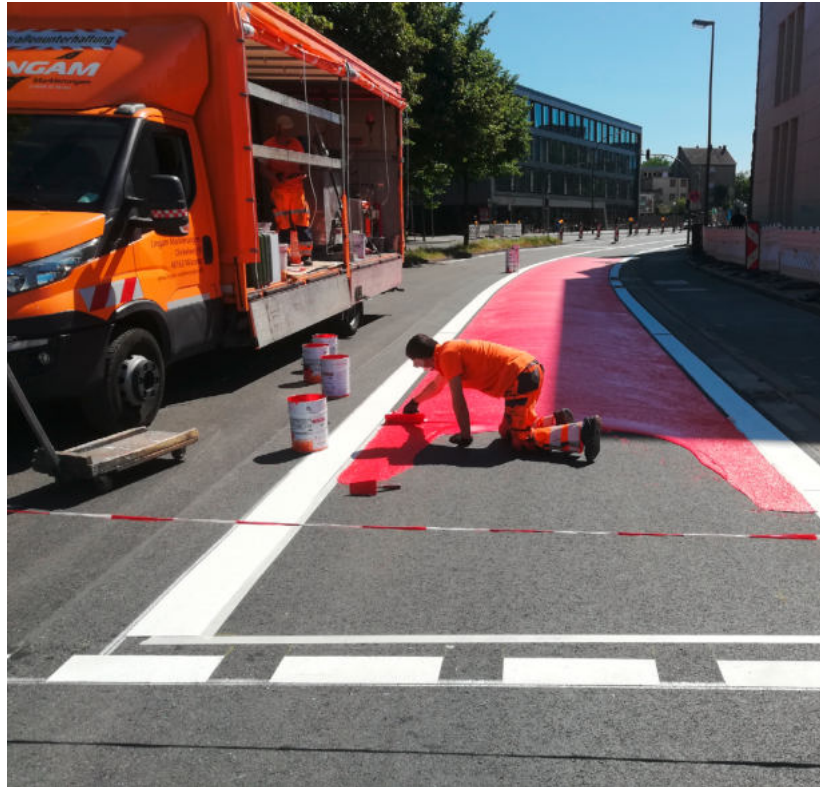
Steinstraße: Zur besseren Orientierung aller Verkehrsteilnehmenden wird der neue Radfahrstreifen rotmarkiert. Eine spezielle Körnung in der Farbe steigert den Halt auf der Fahrbahn.
