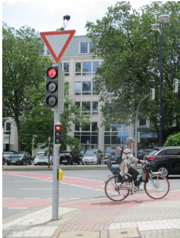
Knotenpunkt Bahnhofstraße / Königswall: Eine neue rote Fahrradfurt für linksabbiegende Radfahrende von der Bahnhofstraße auf den Königswall. Der Bordstein wurde für die Anbindung abgesenkt.
