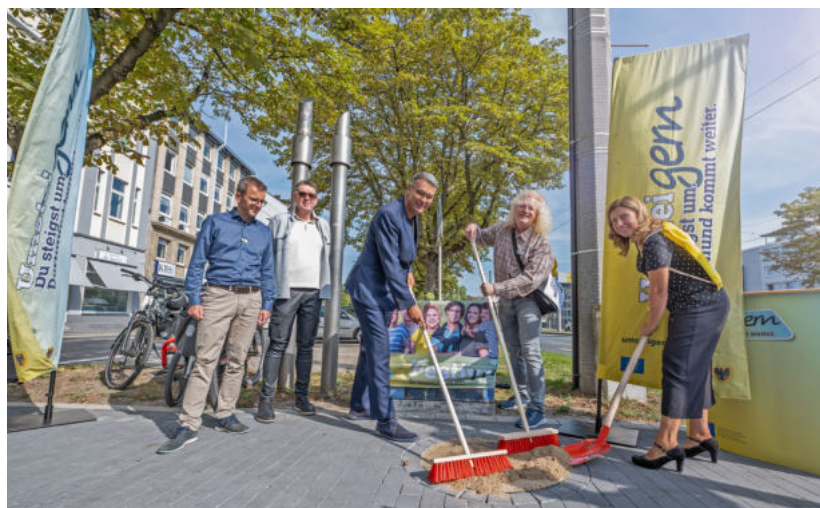
Radwall: Gemeinsam legten OB Thomas Westphal, Friedrich Fuß (Bezirksbürgermeister Innenstadt-West) und Sylvia Uehlendahl (Leiterin des Tiefbauamtes) im Beisein von Andreas Meißner (Leiter Emissionsfreie Innenstadt, 1. v. l.) und Torsten Jahnke (Tiefbauamt, 2. v. l.) einen mit Sand abgedeckten Schachtdeckel frei. Darauf ist nun dauerhaft der Name Radwall zu lesen
