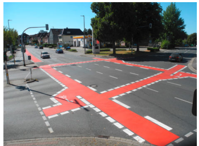
Knotenpunkt Kortental / Wittener Straße: Alle Fahrradfurten wurden rotmarkiert. Zum indirekten Linksabbiegen können Radfahrende die neu markierten Aufstellbereiche nutzen.
