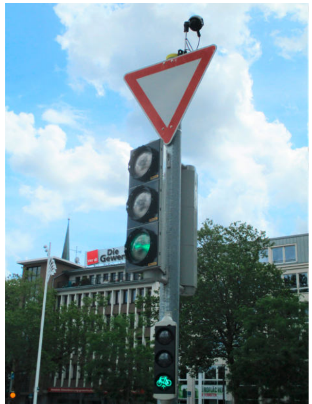
Knotenpunkt Bahnhofstraße / Königswall: Auf dem Ampelmast wurde ein Detektor installiert. Dieser erkennt Radfahrende frühzeitig und steuert die Radverkehrsampel, um linksabbiegende Radfahrende sicher über den Wall zu leiten.
