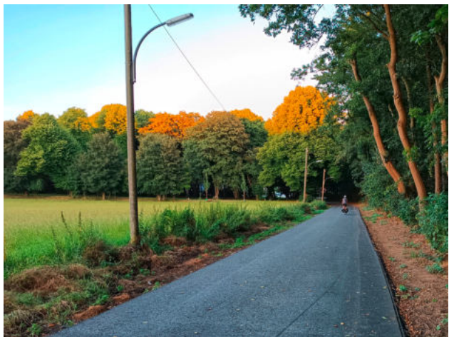
Hessische Straße: Der Verbindungsweg für den Rad- und Fußverkehr zwischen Osterfeld- und Deutsche Straße wurde auf einer Länge von 300 Meter vollständig saniert.
