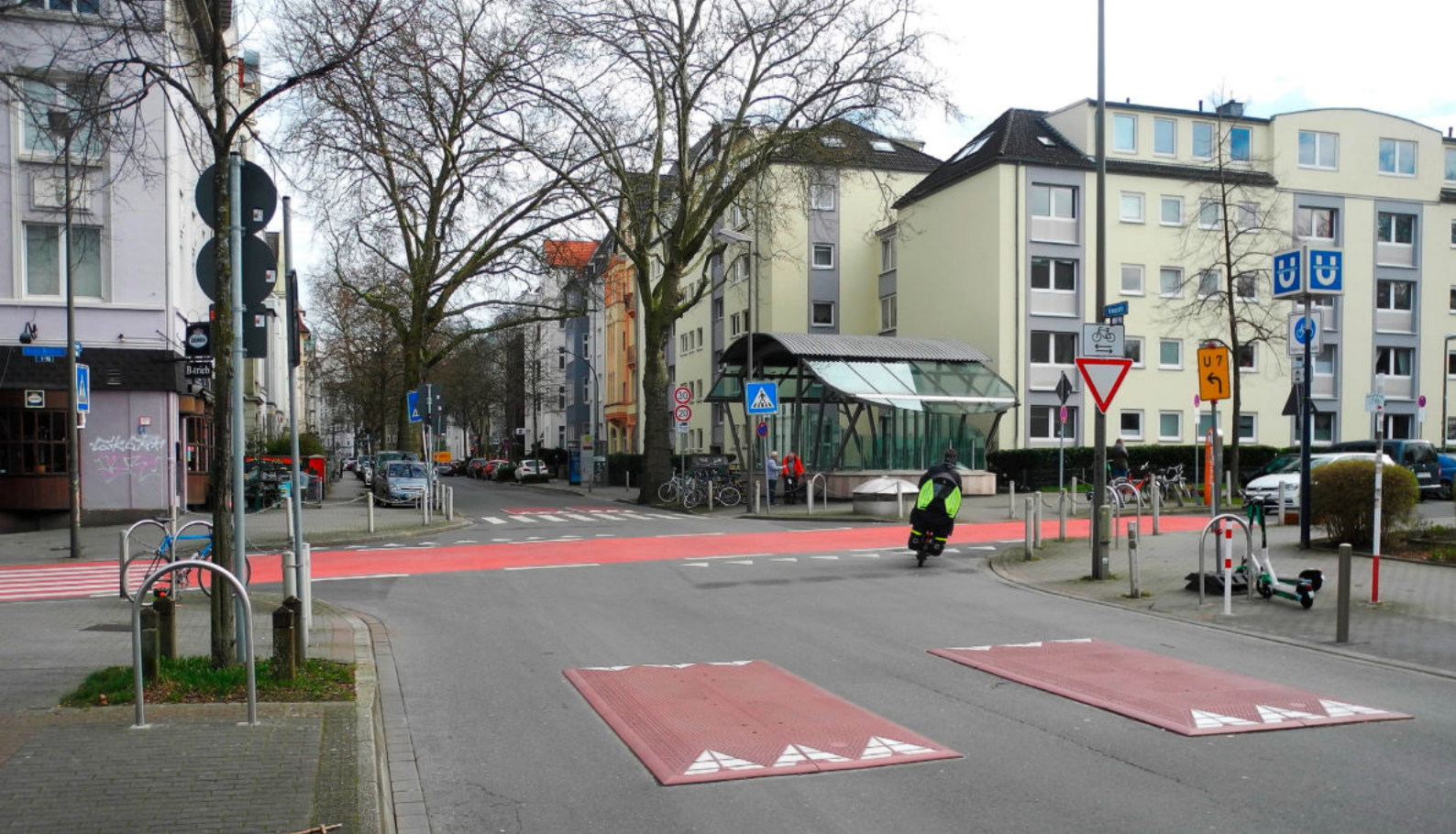
Kreuzstraße: An der Kreuzung mit dem RS1 wurden sogenannte Berliner Kissen montiert. Die Temposchwellen weisen zusätzlich zur Beschilderung und Markierung auf die geänderte Vorfahrt hin.
