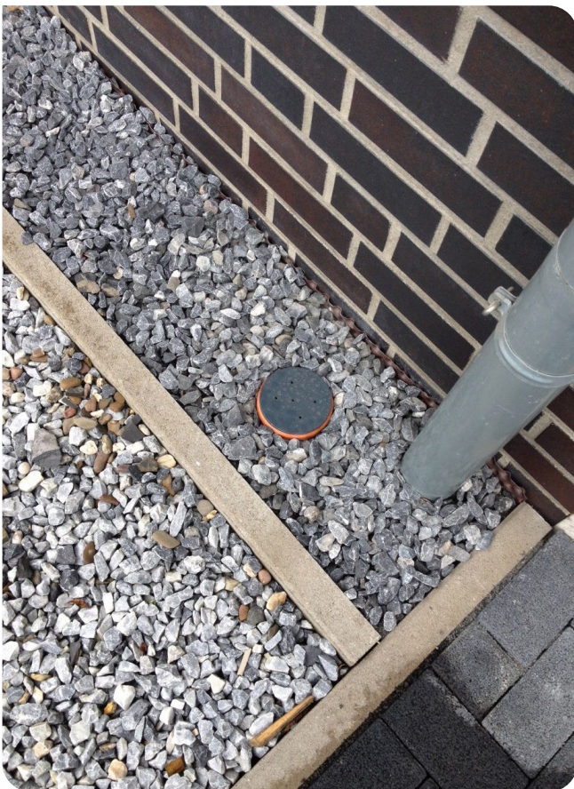
Gebäudeumlaufende Arbeitsraumverfüllung mit Kies
