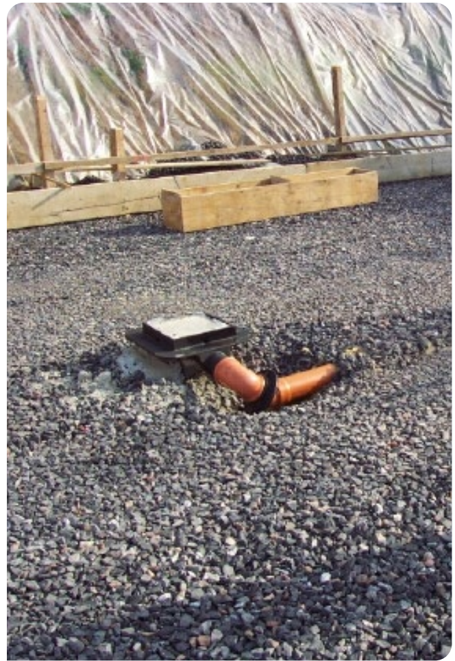
Einbau einer horizontalen Gasflächendränge
