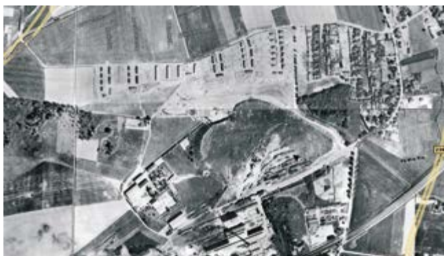
Die Siedlung wurde im Stadtteil Kirchderne nördlich der Westfalenhütte gebaut, o. D.
