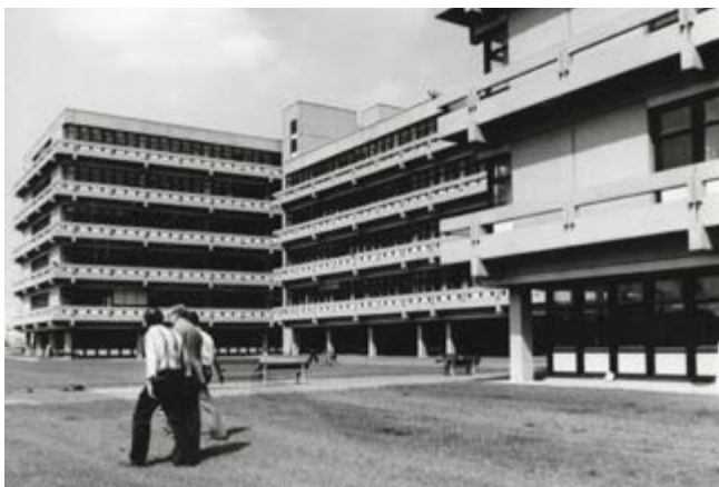
Technische Universität Dortmund: Das Gebäude an der Emil-Figge-Str. 50 von Bruno Lambart wurde mit dem Imbau-System „uniplan Hochschulbau 720“ aus elementierten Fertigteilen realisiert o. D.
