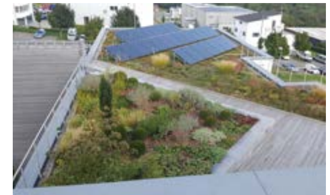
Durch den kühlenden Effekt der Bepflanzung, erhöht eine Dachbegrünung den Wirkungsgrad einer Photovoltaik-Anlage.
