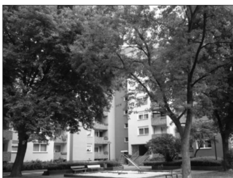
Bild 70 & 71: Ein gut durchmischter und teilweise bereits aufgewerteter Wohnungsbestand
