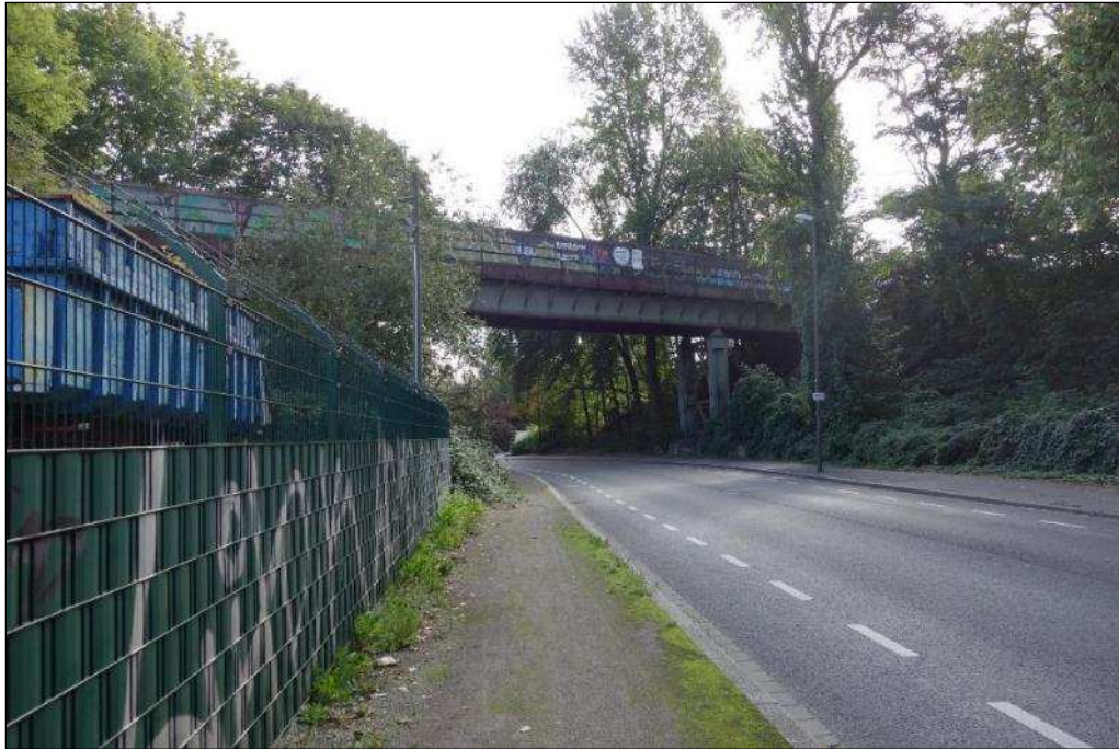
„Weiterführung“ des Emscher-Weges auf Franziusstraße über Schutzstreifen
