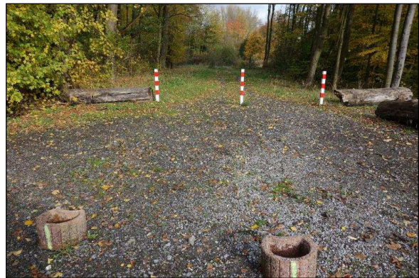
Abzweig Richtung Osten, Höhe Pumpstation
