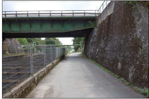
Eisenbahnbrücke Emscher-Weg (Quartierseingang), Richtung Süden
