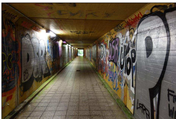
Fußgängerunterführung, Richtung Norden
