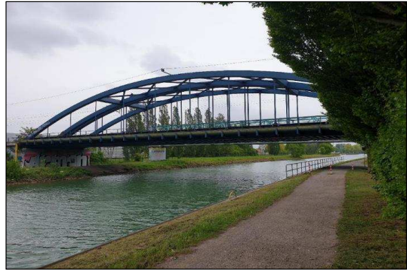
Kanal-Fuß- und Radweg, Richtung Süden, barrierefreier Übergang zum Wohngebiet
