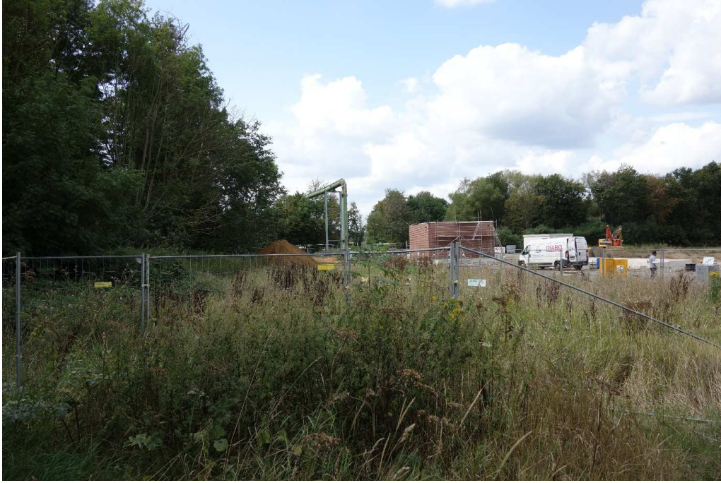
Baustelle nördlich der Eisenbahnbrücke, Richtung Westen
