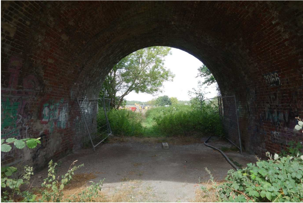
Eisenbahnbrücke, Richtung Norden
