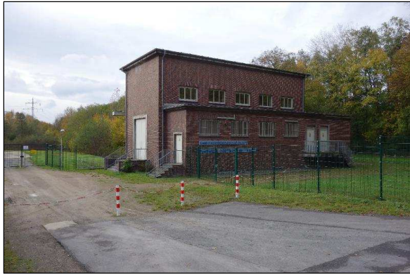
Zu 2: Pumpstation der Emschergenossenschaft Mühlenkampsiepen/Nettebach
