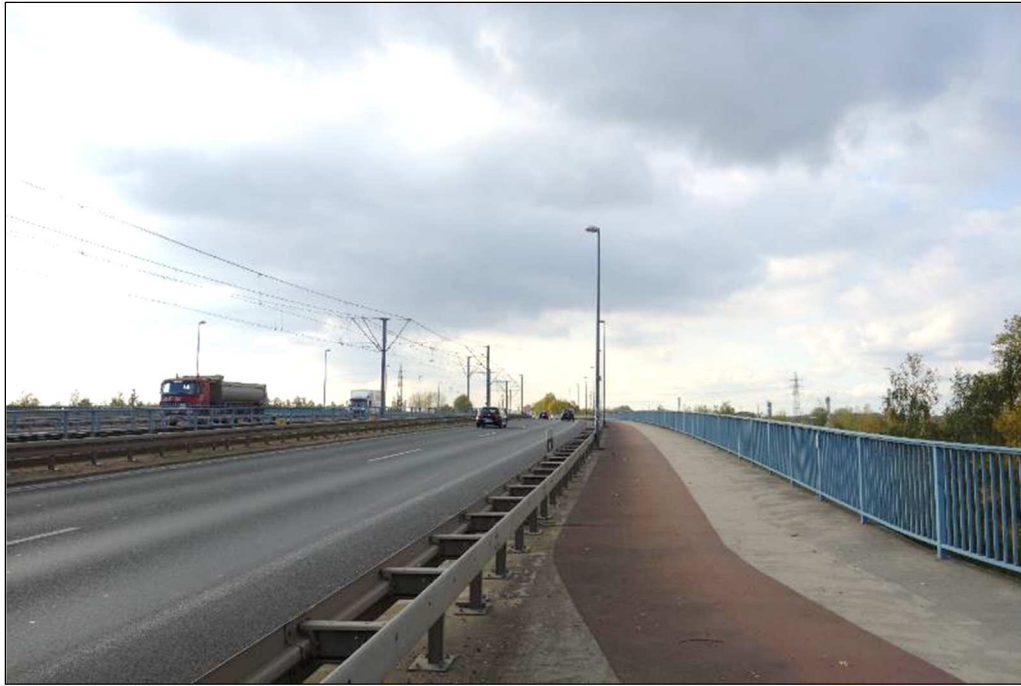
Radweg Richtung Westen (siehe Gebietsübergang Nr. 9)
