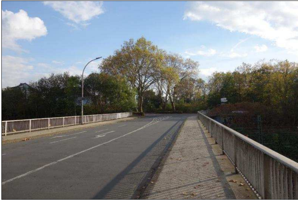
Eisenbahnbrücke Lange Straße Richtung Süden
