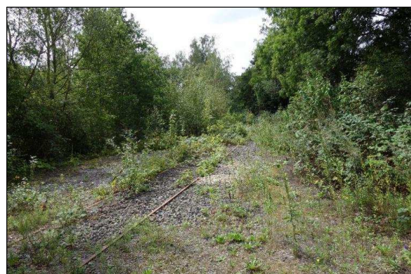
Fuß- und Radweg zum Deusenberg (alte Gleisanlagen), Richtung Westen
