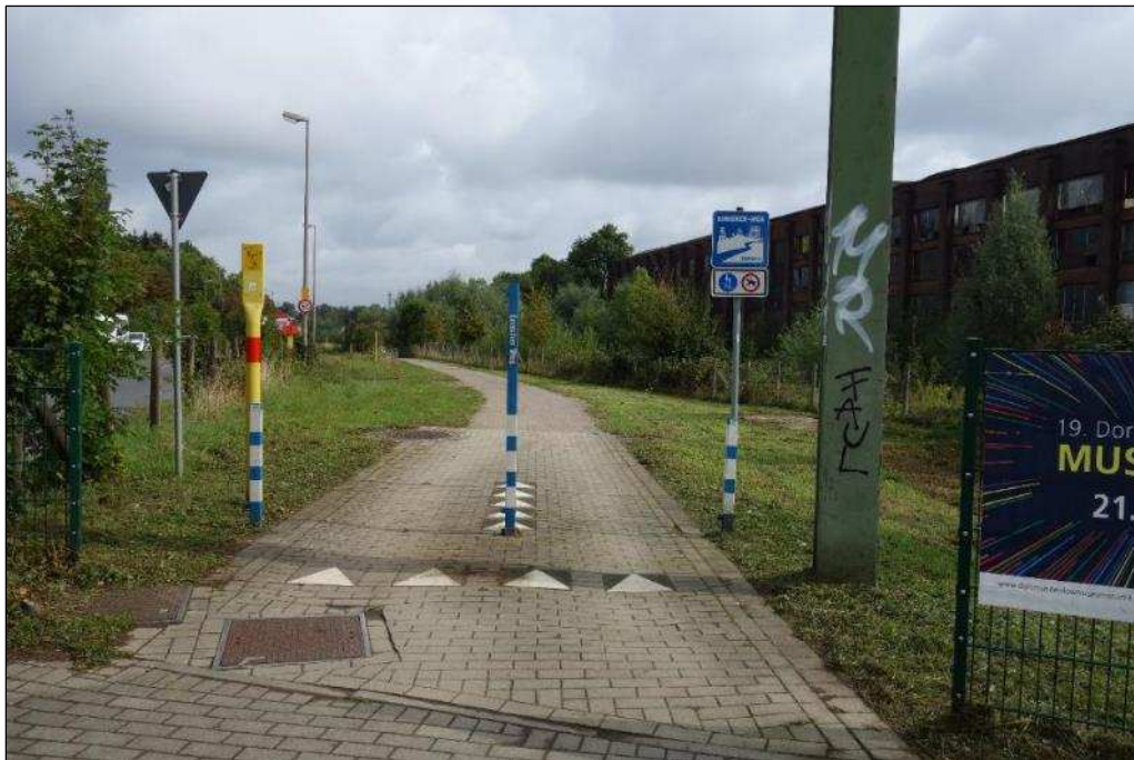
Emscher-Weg Richtung Norden (parallel zur Dorstfelder Allee)
