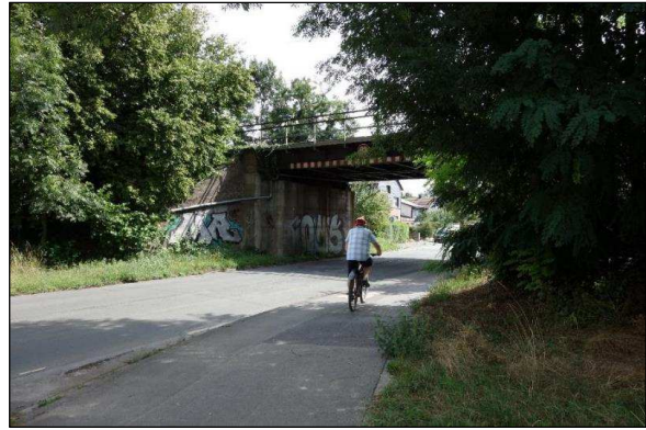
Deusener Straße in Richtung Süden (Deusen)
