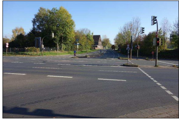
Emscherallee Richtung Bahnhof Mooskamp (Niedernette)
