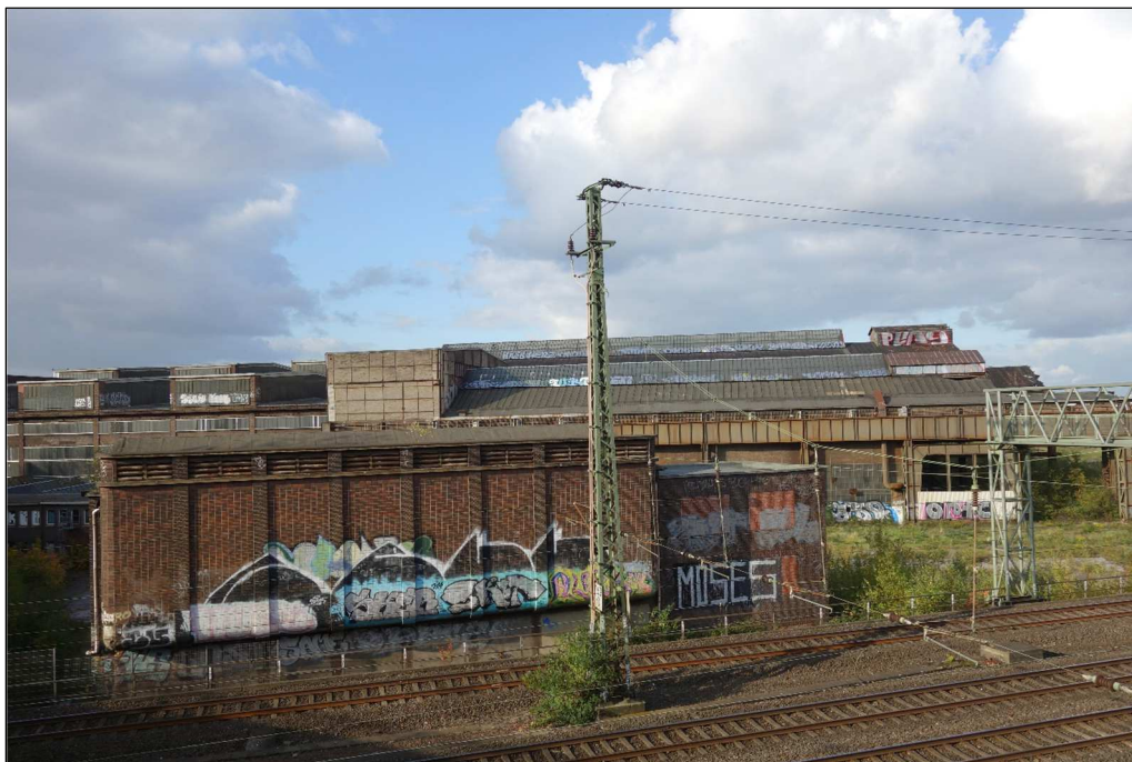
Ehemaliges HSP-Gelände, Blick von der Dorstfelder Brücke Richtung Norden
