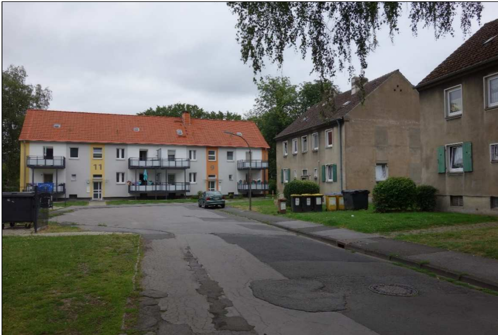
Basenachstraße nach der Renovierung und ursprünglicher Bauzustand
