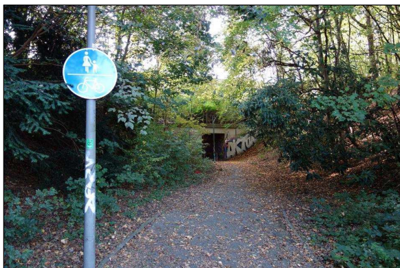
Zugangsbereich Fußgängerunterführung, Richtung Süden
