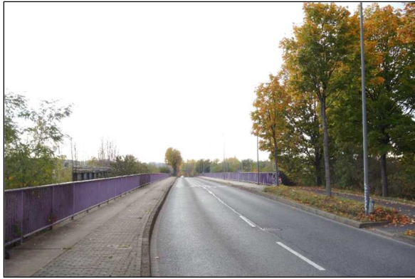
Königsbergstraße, Brücke über Westfaliastraße Richtung Süd-Westen
