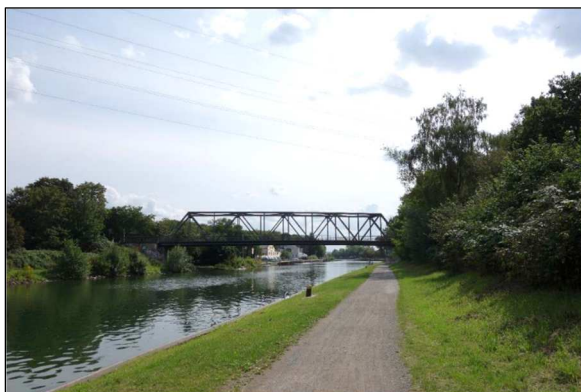
Kanalbrücke Gebietseingang Weidenstraße, Richtung Süden
