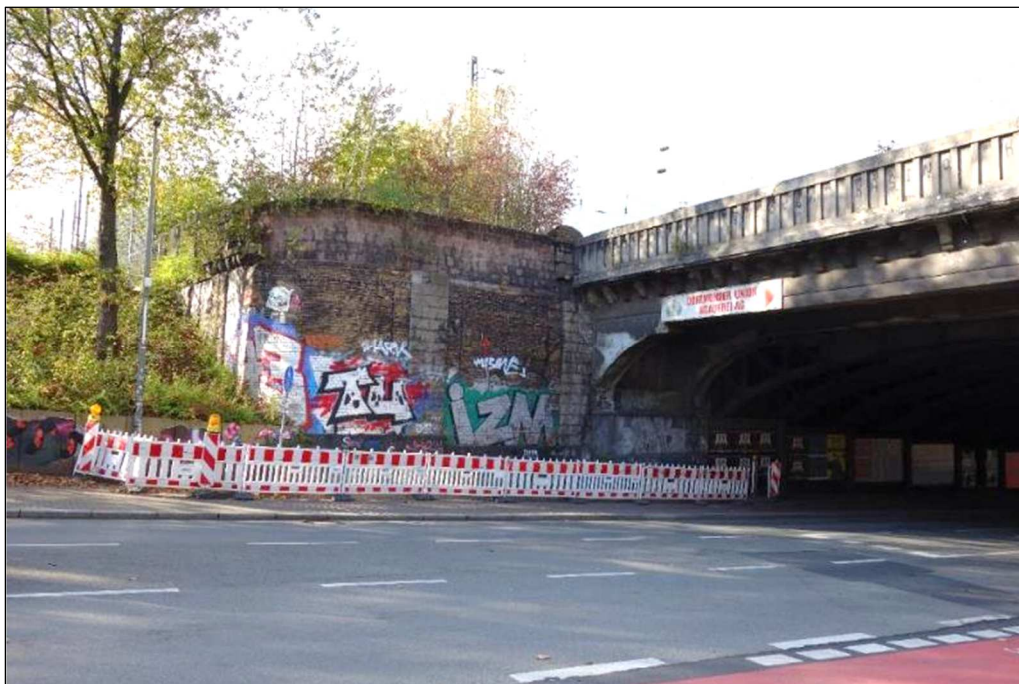
Unionstraße Richtung Norden, erste Eisenbahnbrücke
