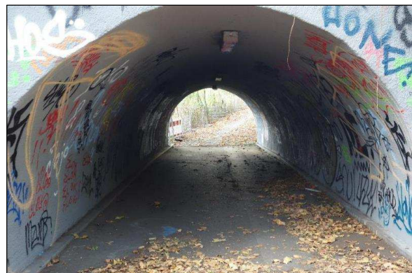
Zugang zur S-Bahn Richtung Unna und zum Hahnenmühlenweg
