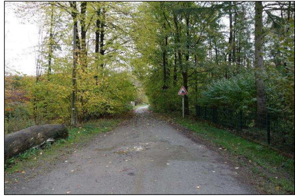
Westhusener Straße Richtung Süden (Huckarde), Höhe Pumpstation
