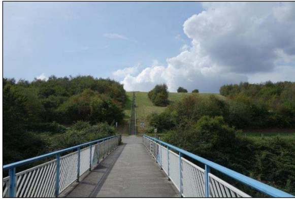
Emscherbrücke aus Richtung Ährenweg, Richtung Westen mit „Kreuzung“ Emscher-Weg
