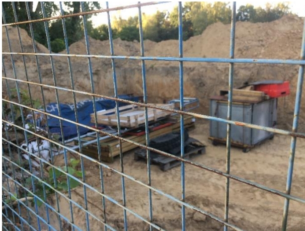
Vorbereitung der Fläche für das museale Ausstellungsgebäude am Bahnhof Mooskamp
