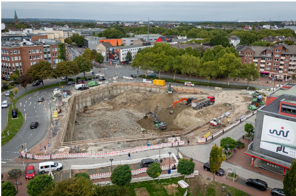
Die Baugrube fürs Quartier Burgtor: Nach dem Abschluss der Ausgrabungen gingen die Arbeiten weiter. © Roland Gorecki
