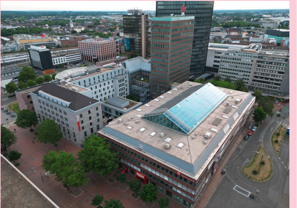
Das Sparkassen-Hochhaus soll ebenso wie das Kundencenter (vorn im Bild) abgerissen und durch einen energiesparenden Neubau ersetzt werden. © Patrick Lambertus
