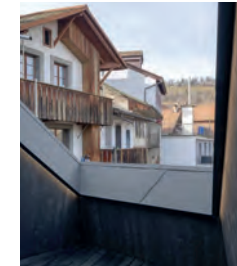
Aufstockung in Moudon - outsider.archi
