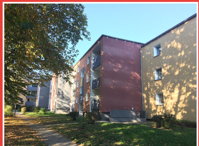
Kiepeweg 22 nach der Sanierung
