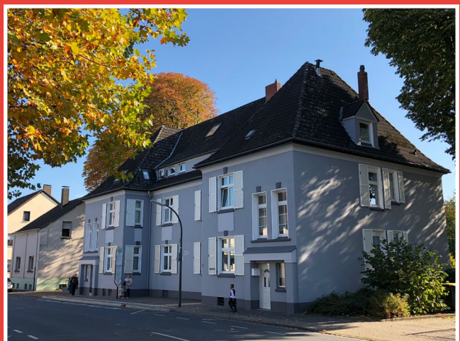
Westerfilder Straße 39 nach der Sanierung
