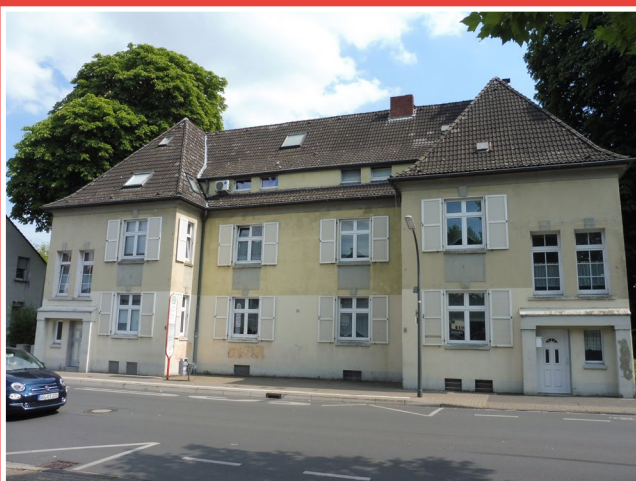
Westerfilder Straße 39 vor der Sanierung
