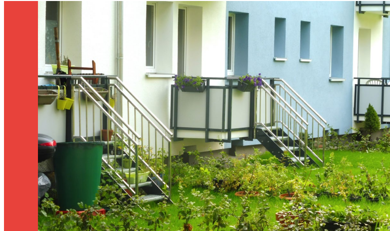
Mietergärten Am Kirchenfeld 3-5 einschl. Treppenanlage von den Balkonen im Erdgeschoss
