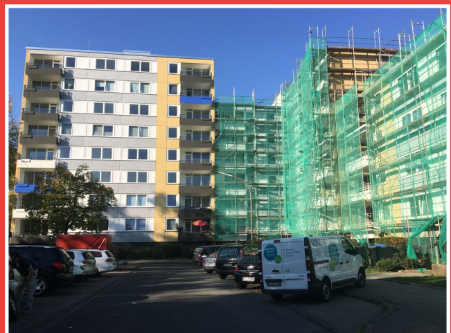
Gerlachweg 5-7 während der Sanierung
