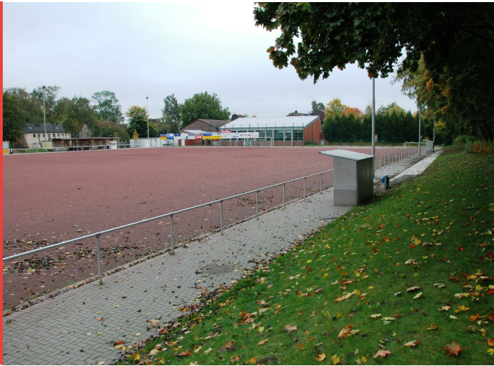
Sportplatz vor dem Umbau
