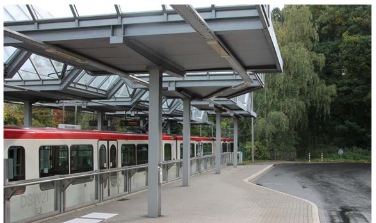
Stadtbahn- und Bushaltestelle Westerfilde
