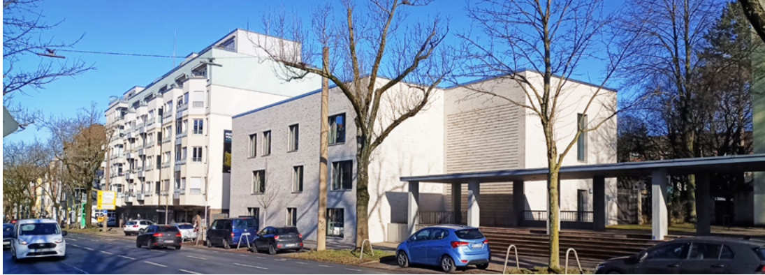
Neu realisierte Kita in der Kreuzstraße 66b. Bild: Stadt Dortmund/Ingo Strumberg
