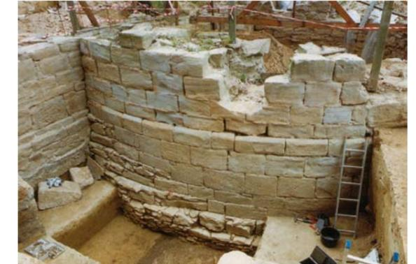
Der Adlerturm während der Ausgrabungskampagne 1990. Gut zu erkennen ist die Baufuge zwischen Stadtmauer und vorgesetztem Turm sowie am Turm der Verlauf der ehemaligen Stadtgrabenböschung. Im Gegensatz zum früher freiliegenden Mauerteil aus regelmäßig behauenen Quadern, ist das Turmfundament aus kleineren Bruchsteinen aufgeschichtet.
