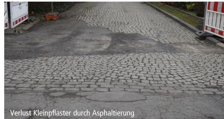
Verlust Kleinpflaster durch Asphaltierung
