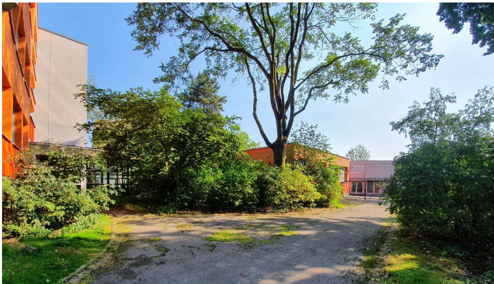
Abbildung 2: Blick auf die südlichen Schulgebäude, Blickrichtung: Nordosten, eigene Aufnahme vom 10.08.2020
