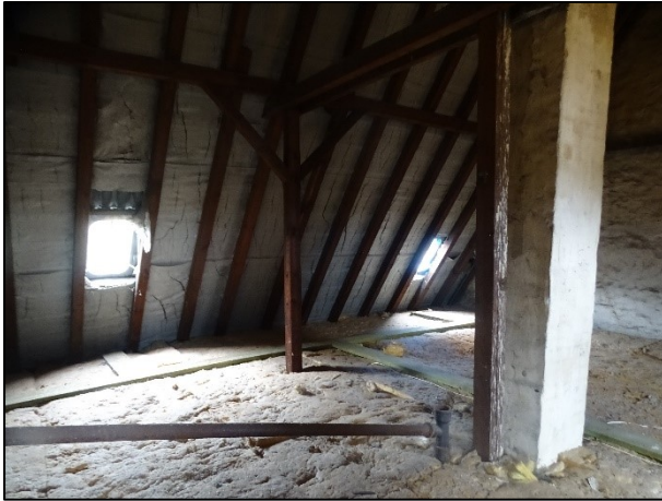
Abb. 19: Dachboden des nördlichen Schulgebäudes ohne Hinweise auf Tiere.
