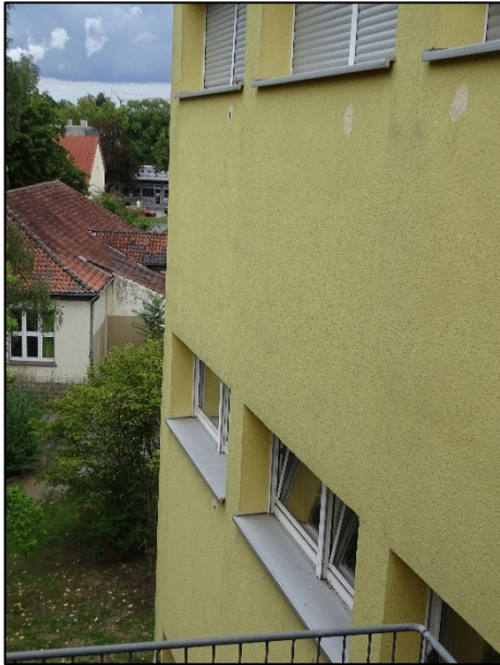
Abb. 23: Zwei mit dem Endoskop kontrollierte Löcher an der Westfassade. Ins untere Loch flog zwischenzeitlich eine Blaumeise ein. Ein Hinweis auf ein ehemaliges Brutgeschehen erfolgte nicht.
