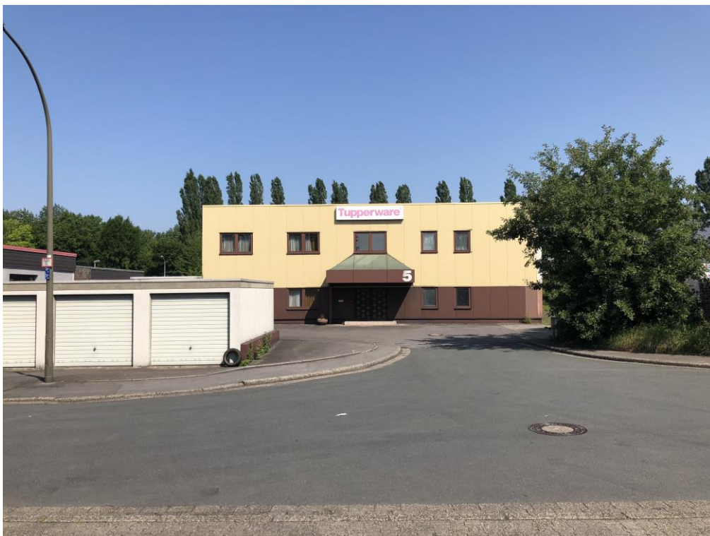
Abbildung 4 Blick auf im Untersuchungsgebiet befindliche Gebäude mit Garagen
