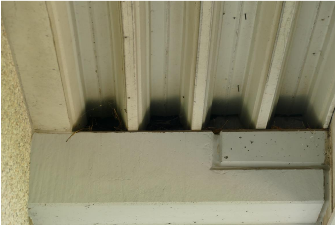
Abbildung 4: Ansammlung von Zweigen, potenziell ein einfaches Nest, unter dem Vordach des abzureißenden Gebäudes.
