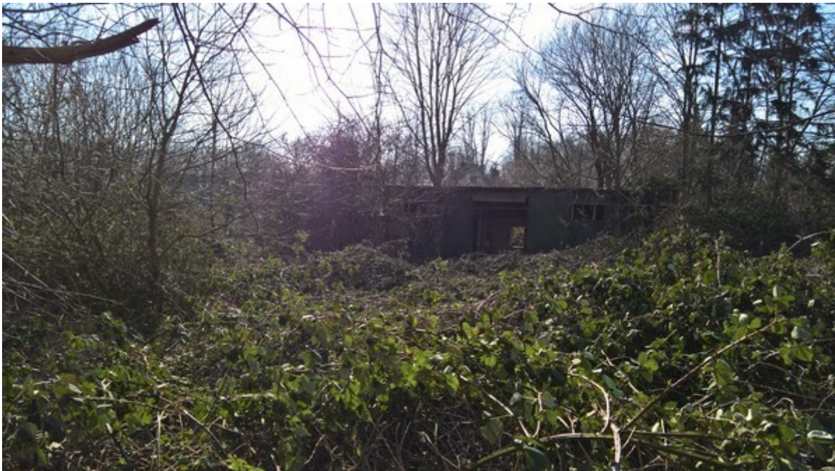
Abbildung 5: Brombeerstrukturen nördlich des Walls, im Hintergrund der ehemalige Stall (Stand Februar 2018)
