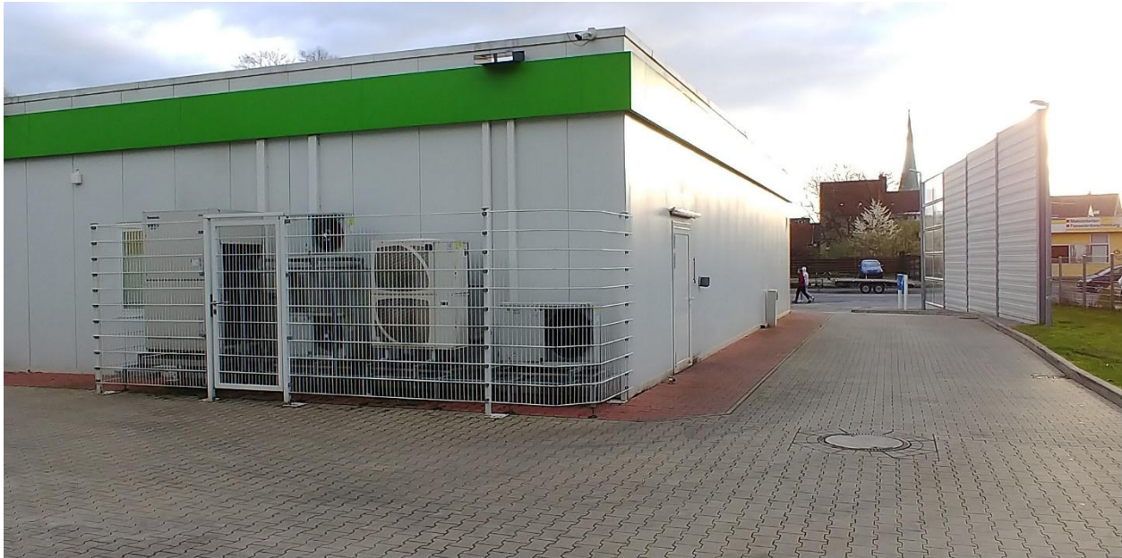
Abbildung 11: Haustechnische Anlagen an der östlichen Fassade des Tankstellengebäudes und vorhandene Schallschutzwand
