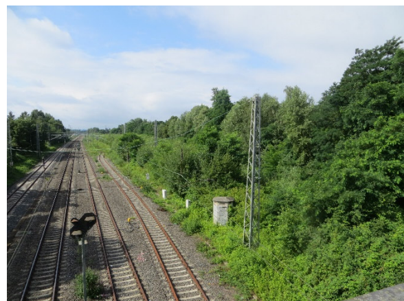
Gehölzaufwuchs im Bereich der ehemaligen Gleise (Blick von der Brücke über die DB-Strecke)
