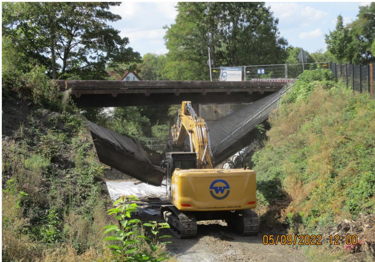
Foto: Abrissarbeiten Brücke am Remberg
