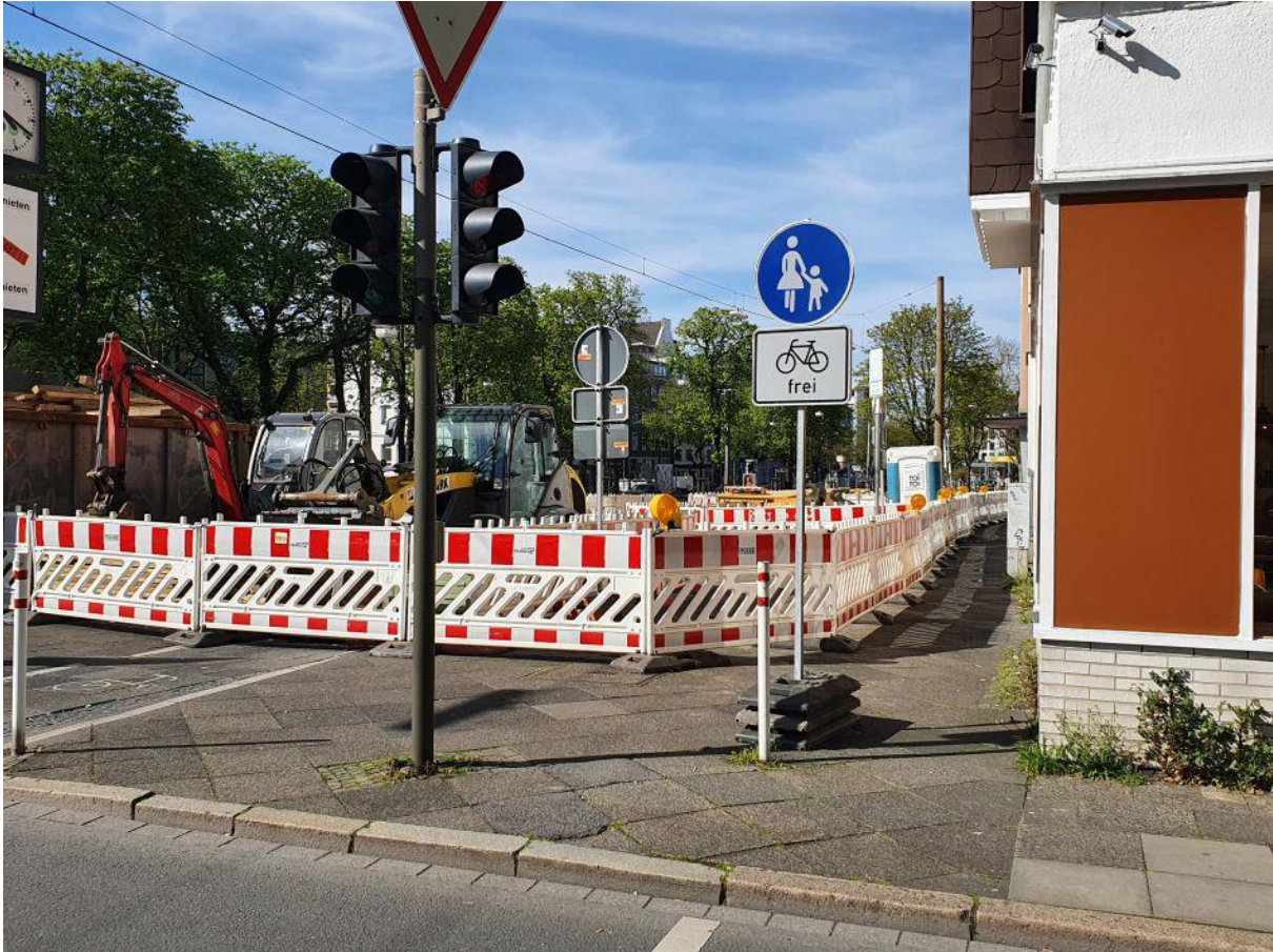
Ostwall Höhe Arndtstraße: Sechs Fahrstreifen für den Kfz-Verkehr, Enge für Fuß- und Radverkehr.
