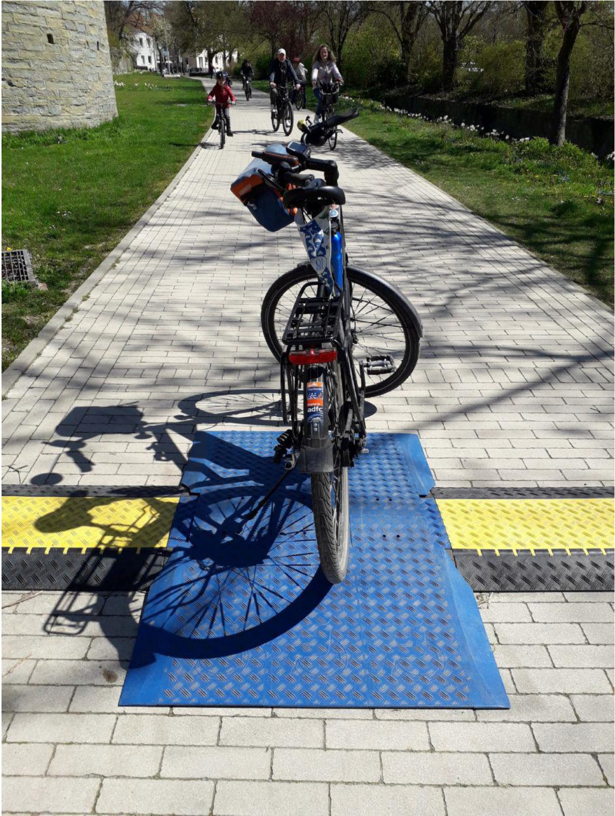
Details sind wichtig. Positivbeispiel aus Soest: Barrierefreies Überfahren von Leitungen.
