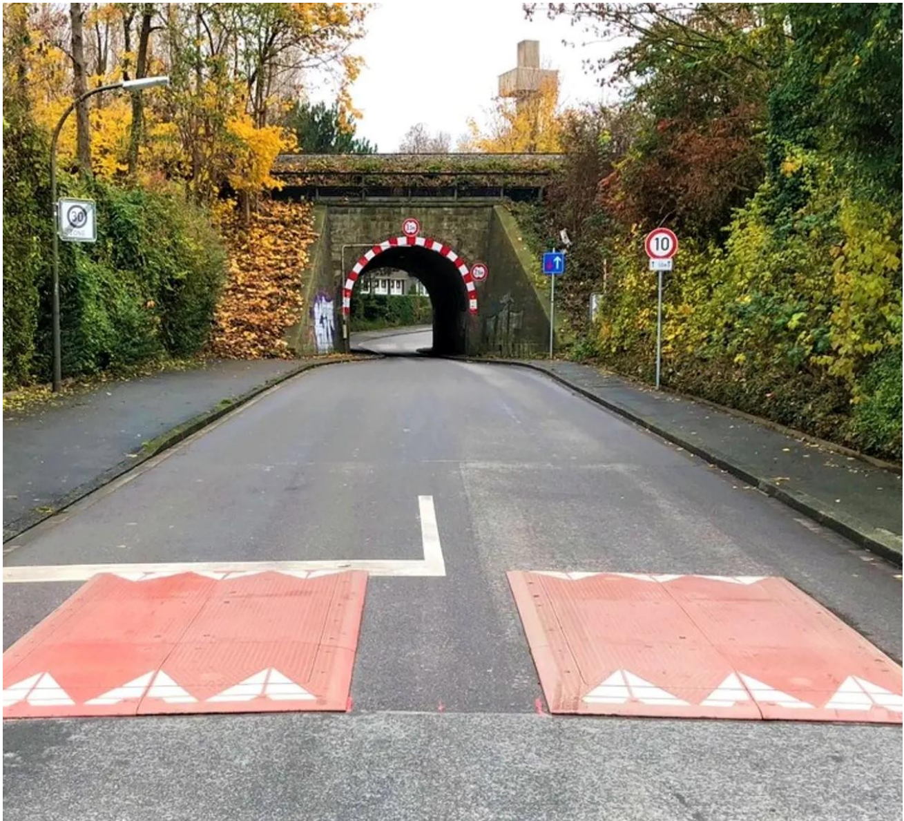
Am Zehnthof: Blick auf die Eisenbahn-Unterführung von der Fahrradstraße Lange Reihe. Aus dieser Richtung dürfen in den nächsten sechs Monaten keine Fahrzeuge kommen. Bild: Stadt Dortmund
