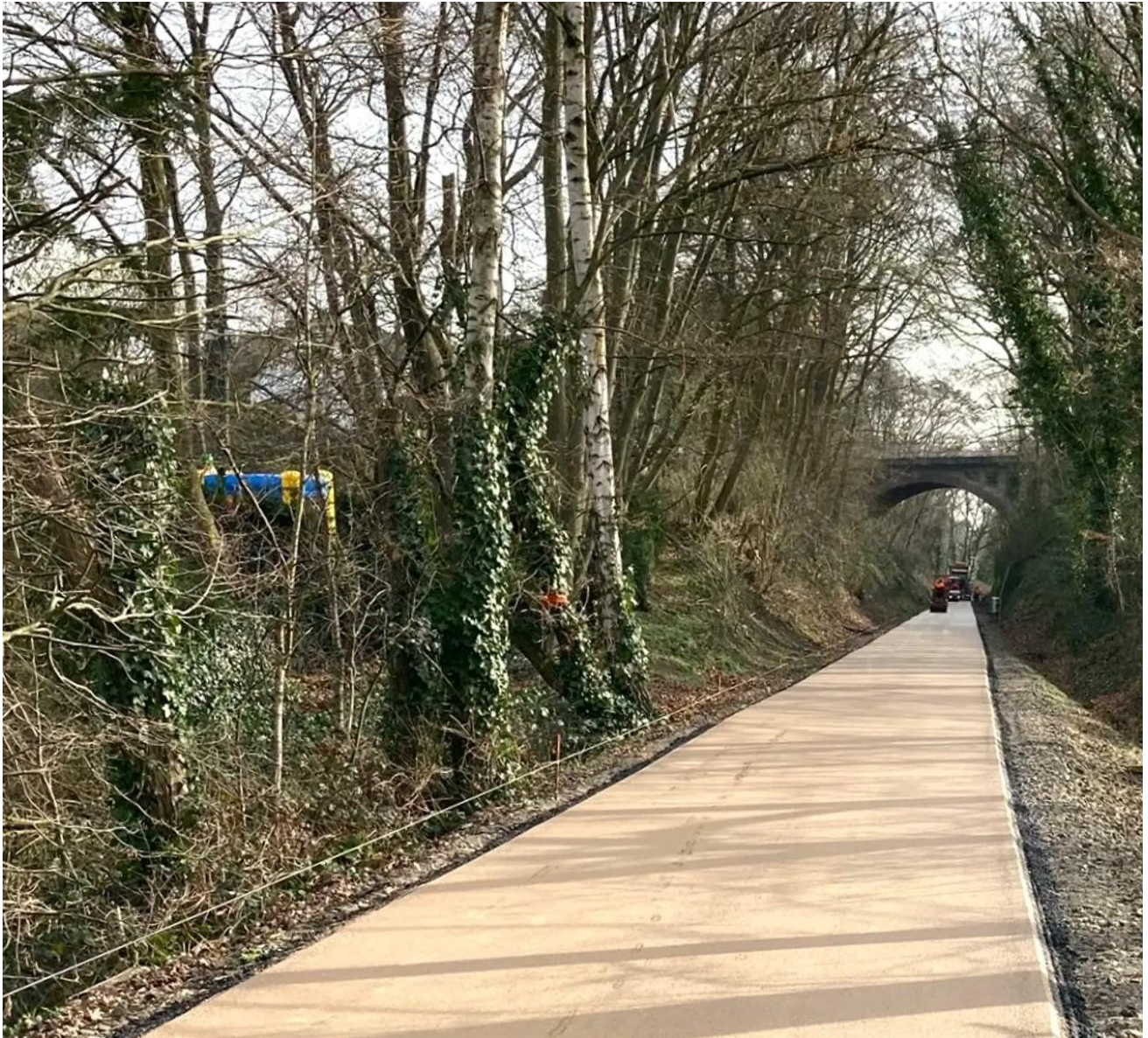
Rheinischer Esel: Heller Asphalt für die letzten beiden Teilstücke der ehemaligen Bahntrasse. Bild: Stadt Dortmund / Jens Reese
