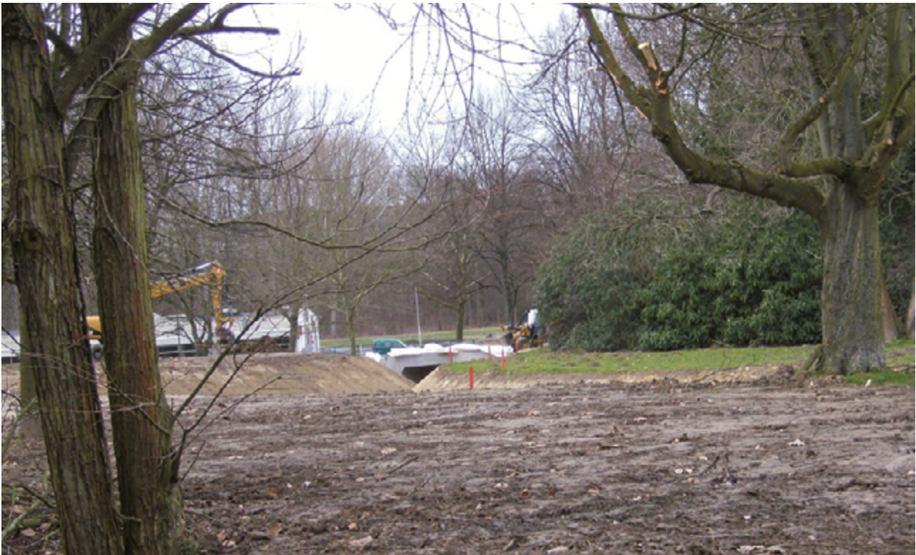
Abbildung 10: Bauarbeiten Oespler Bach (Gewässer der Emscher-Genossenschaft), Stadtpark Marten
