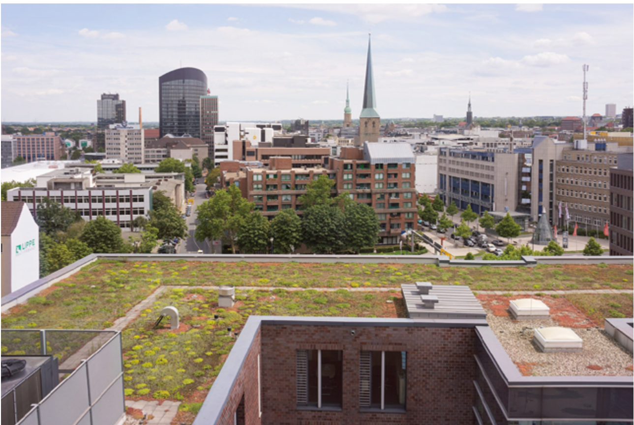
Abbildung 15: Dachbegrünung in der City
