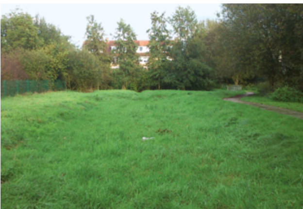
Abbildung 23: Retentionsmulde in einer öffentlichen Grünanlage
