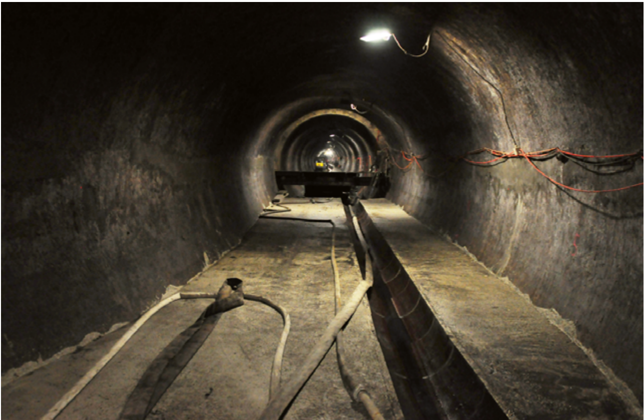
Abbildung 28: Einbau der Trockenwetterrinne
