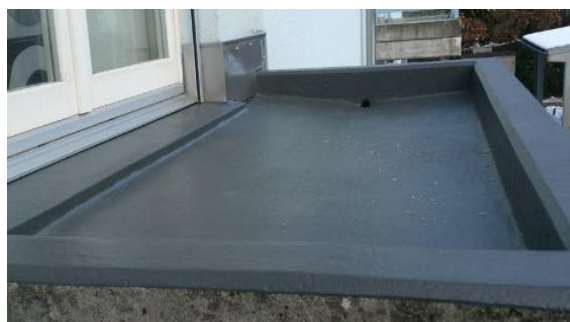
Dach mit Wasserzwichenspeicherung (Foto: K.PLAN)
