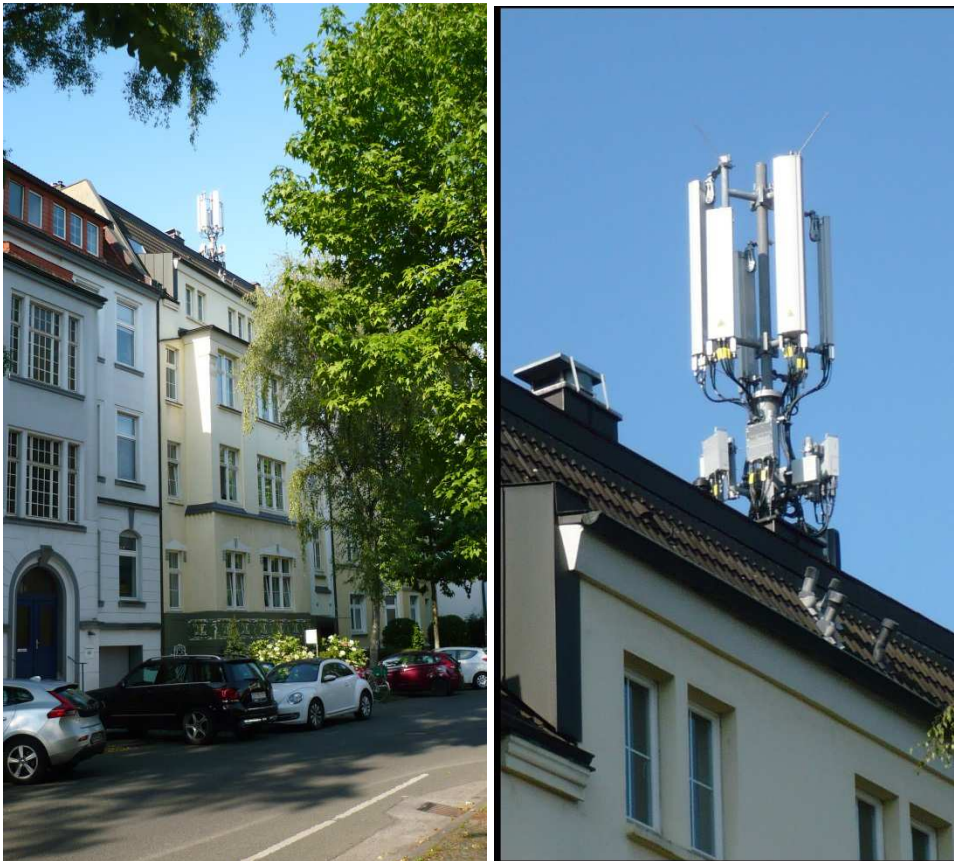
Abb. 1, 2: Ansicht der Kronprinzenstraße in Richtung Gebäude Nr. 103 (links), aufgenommen von der gegenüberliegenden Straßenseite Höhe Haus 107; Detailansicht der Sendeanlage auf dem Dach (rechts)
