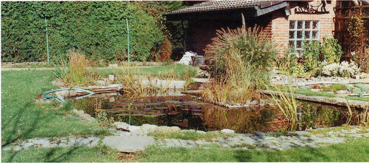
Muldenversickerung mit vorgeschaltetem Gartenteich
