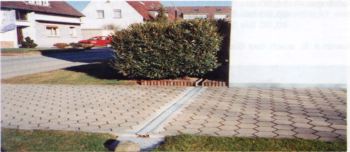
Querung der Hofeinfahrt durch abgedeckte Formrinne
