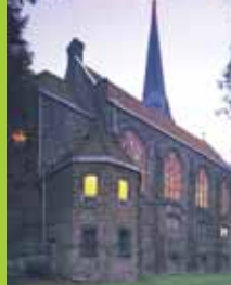
Dreieinigkeitskirche Wellinghofer Amtsstraße 25 44265 Dortmund
