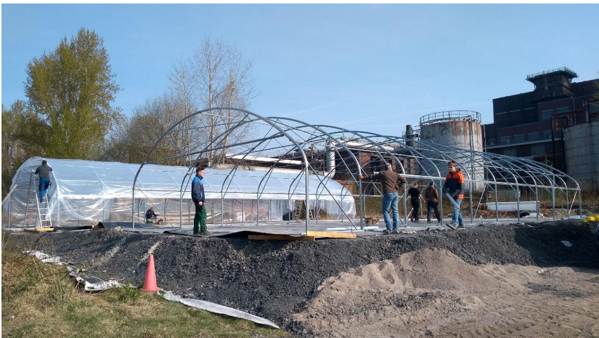
Errichtung der Foliengewächshäuser im April 2022 (Foto: die Urbanisten e.V.)
