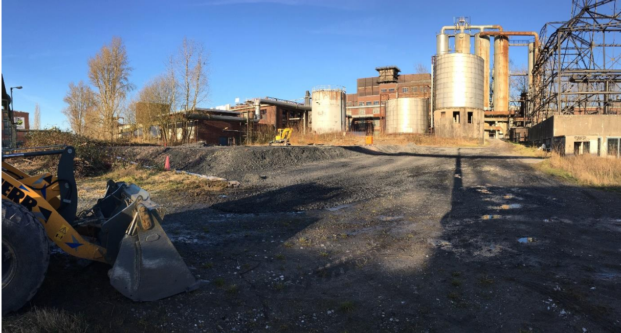
Vorarbeiten für die Erstellung des Fundaments im Februar 2022 (Foto: Dagmar Knappe)
